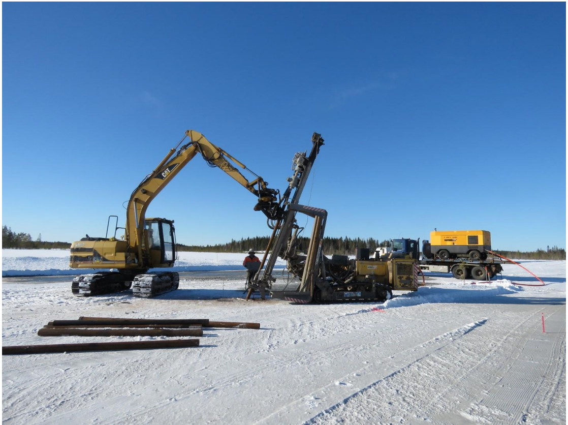
Kuva 2-5. Porapaaluperustuksen tekoa suoalueella, jossa työalue on jäädytetty.
