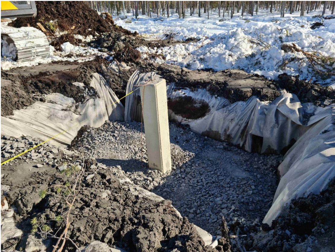
Kuva 2-4. Pylvään perustuselementin asentaminen.
