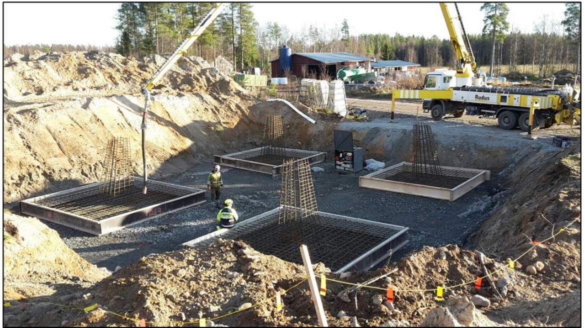
Kuva 3-5. Vapaasti seisovan pylvään perustuksen pohjatöitä.
