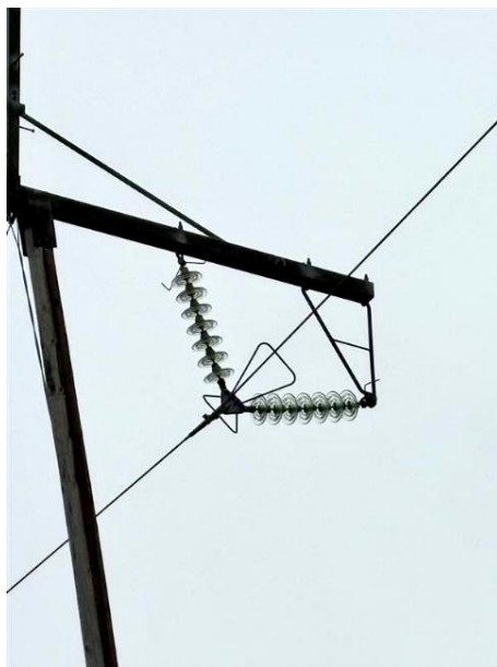
Kuva 7-7. Voimajohtopylvään eristimiä, joissa koronapurkauksia voi esiintyä. Bild 7-7. Kraftledningsstolpes isolatorer i vilka det kan förekomma koronurladdningar.
