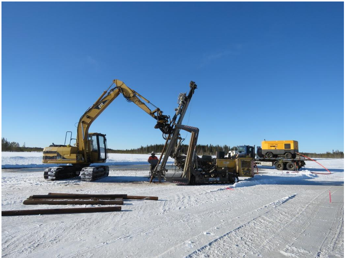
Kuva 3-6. Porapaaluperustuksen tekoa suoalueella, jossa työalue on jäädytetty.
