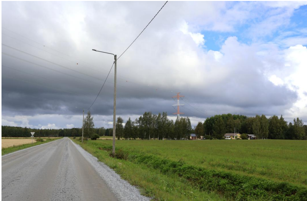
Kuva 8-26. Valokuva Hästöntieltä pohjoiseen. Kameran asetuksissa polttoväli 18 mm. Kuvassa näkyy asuinrakennuksia Kruunupyynjoen varressa Rudvikin alueella. Nykyinen voimajohtopylväs erottuu maisemassa selvästi ja nousee korkeana rakenteena puuston yläpuolelle. Peltoauekealla voimajohtoihin on kiinnitetty huomiopalloja.
