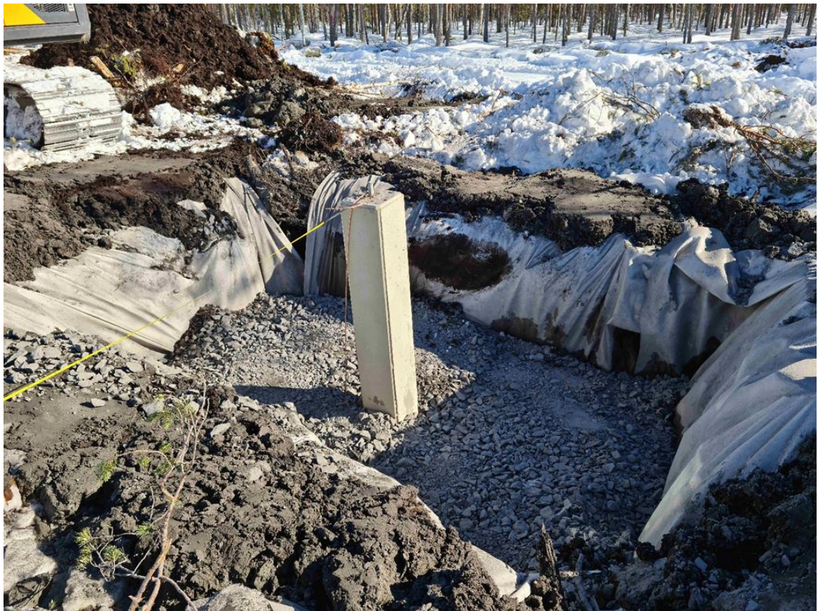
Kuva 3-4. Pylvään perustuselementin asentaminen.
