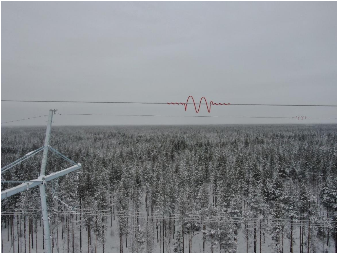
Kuva 10-5. Lintujen törmäysriskiä voidaan pienentää merkitsemällä ukkosjohtimet riskialttiissa kohdissa huomiomerkinnöin.
