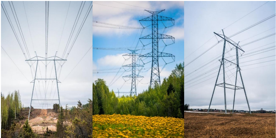
Kuva 4-13. Esimerkkikuvat eri pylvästyypeistä. Vasemmalla haruksin tuettu 400 + 110 kilovoltin portaalipylväs, keskellä vapaasti seisova kahden 400 kilovoltin voimajohtopylväs ja oikealla vapaasti seisova harukseton peltopylväs.
