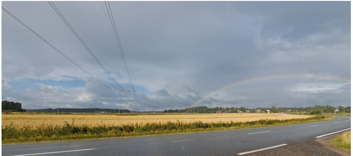
Kuva 8-18. Voimajohto kuvattuna Perkiömäentien ylityskohdasta kohti pohjoista. Kuvassa oikealla asutusta Perkiömäen ja Mäen alueella, alle puolen kilometrin etäisyydellä voimajohdosta.
