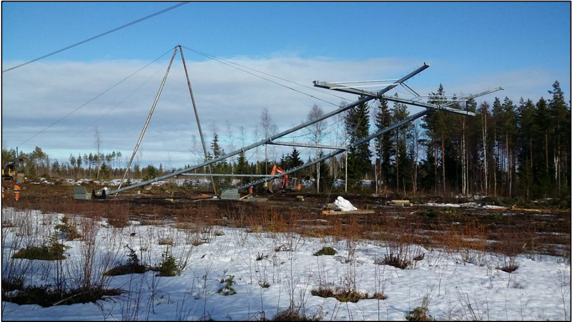
Kuva 3-7. Voimajohtopylvään pystytys.
