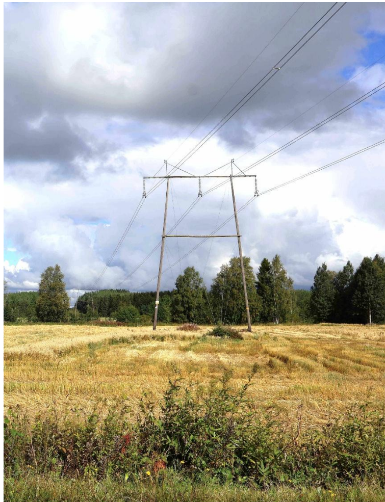
Kuva 7-3. Seinäjoki-Hirvisuo 400 + 100 kilovoltin voimajohdon Ähtävänjoen Natura-alueen ylityspaikka. Kuvassa nykyinen 110 kilovoltin voimajohto. Ähtävänjoki ei erotu kuvassa ympäristöään alempana kohteena vaan jää lähimpien puiden välisen aukon taakse.
