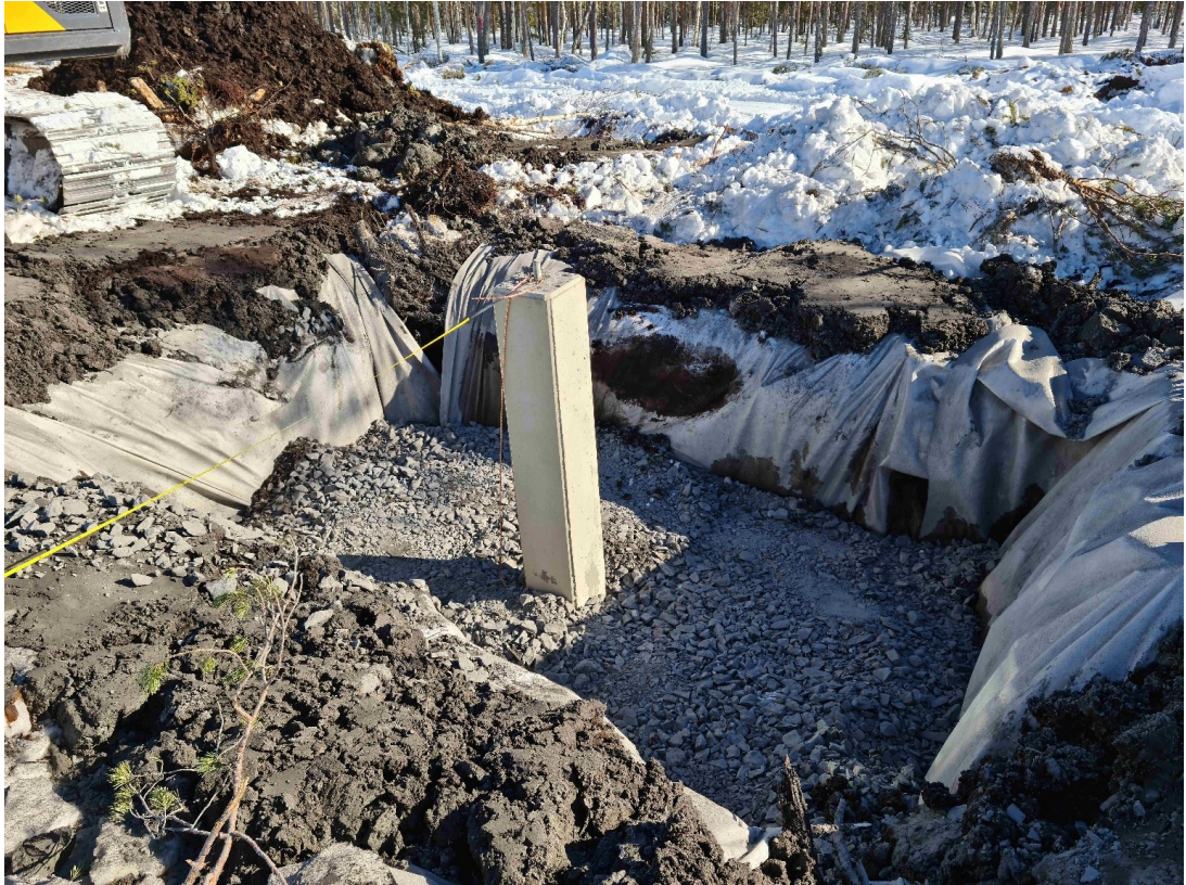
Kuva 3-4. Pylvään perustuselementin asentaminen.
