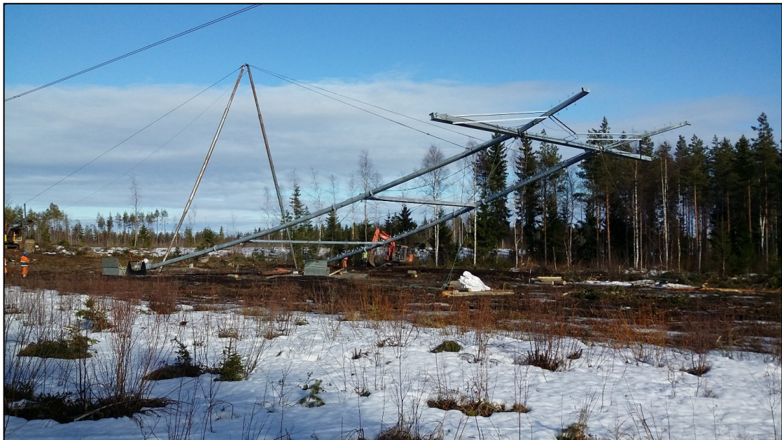
Kuva 3-7. Voimajohtopylvään pystytys.
