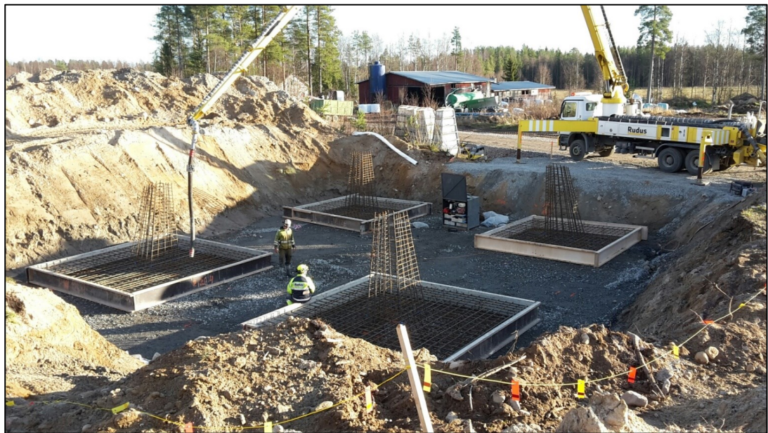
Kuva 3-5. Vapaasti seisovan pylvään perustuksen pohjatöitä.
