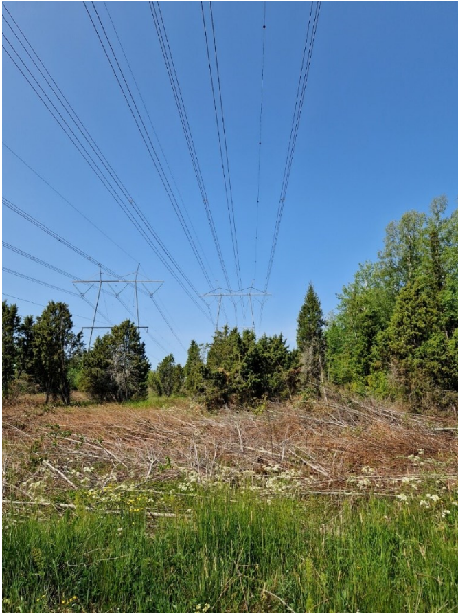
Kuva 3-8. Esimerkki valikoivasta raivauksesta.
