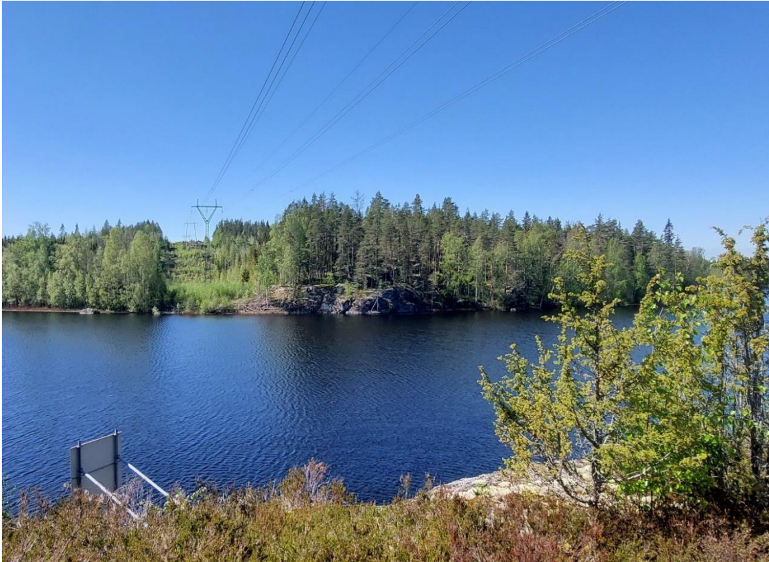
Kuva 73. Nykyinen Vuoksi-Konkapelto voimajohto Ruokolahden Jouhtjärvensalmen yllä, näkymä idästä länteen. Vesistön ylityksessä nykyinen ja uusi voimajohto voidaan asettaa yhteispylväisiin.
