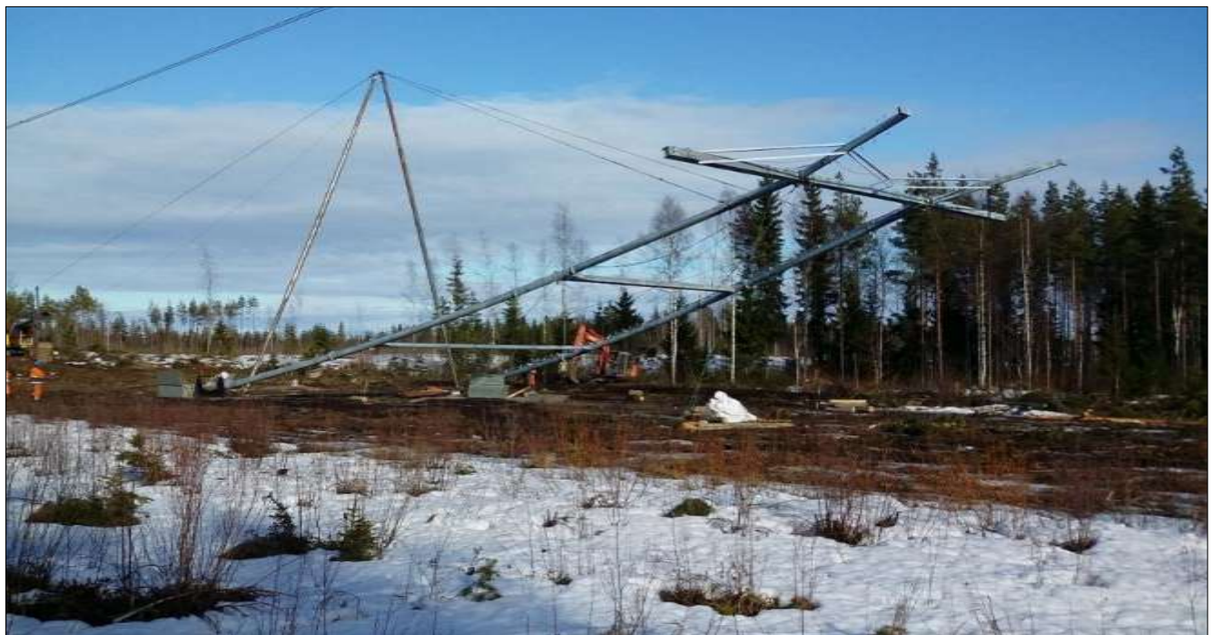
Kuva 13. Voimajohtopylvään pystytys.
