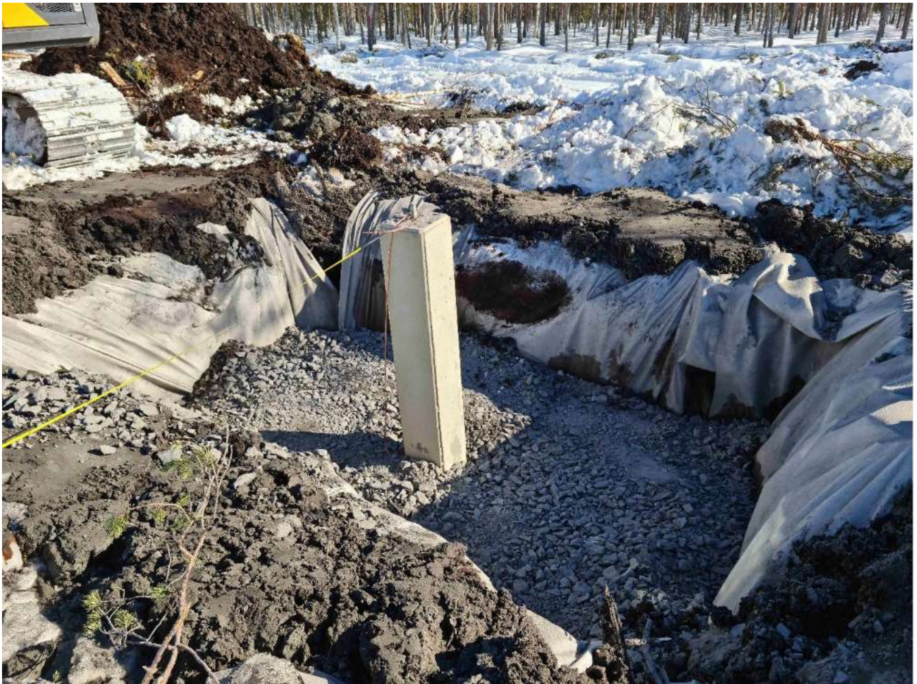
Kuva 10. Pylvään perustuselementin asentaminen.
