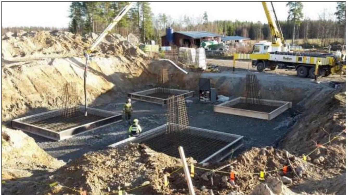
Kuva 11. Vapaasti seisovan pylvään perustuksen pohjatöitä.
