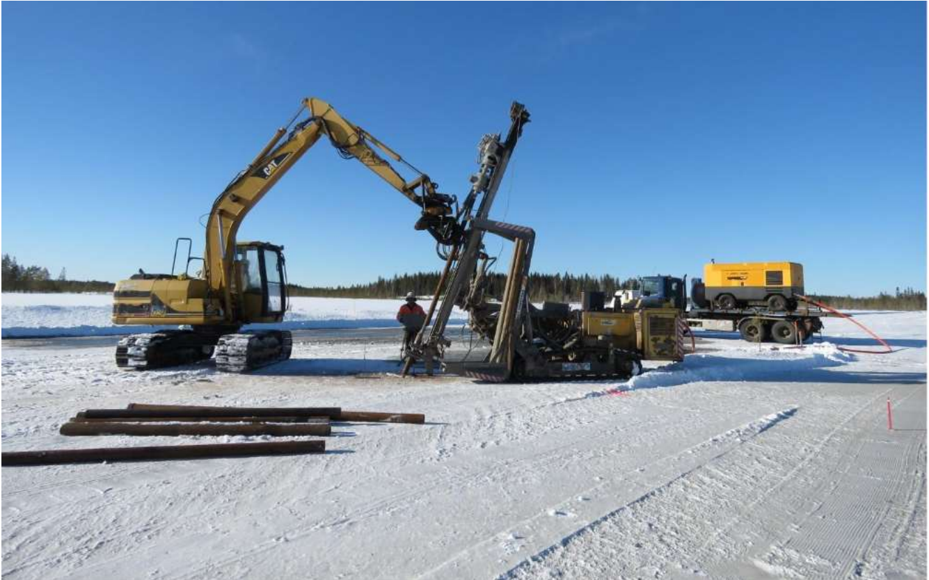
Kuva 12. Porapaaluperustuksen tekoa suoalueella, jossa työalue on jäädytetty.
