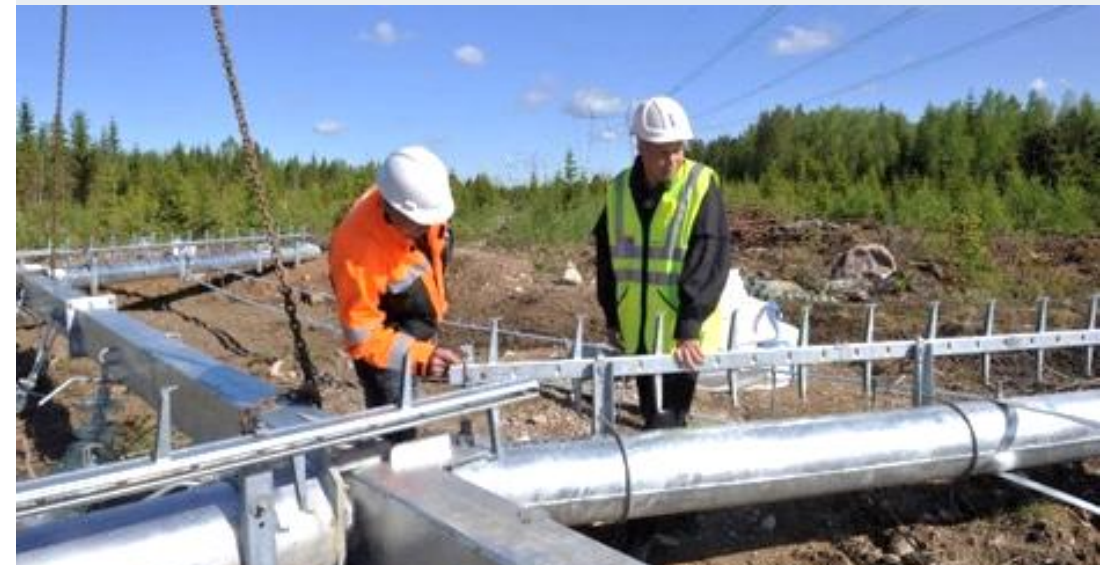
Hyvinkää – Hikiä transmission line construction site.
