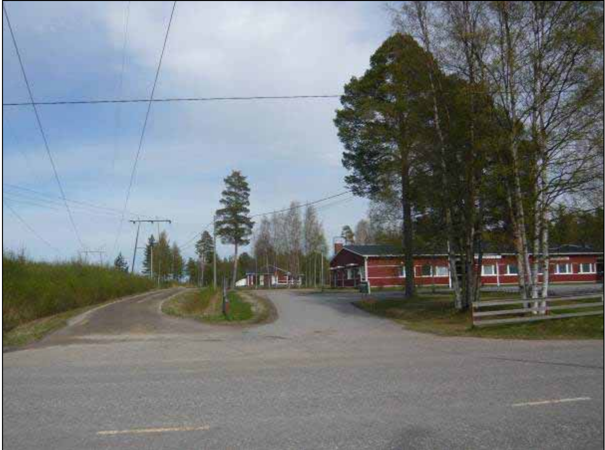
Kuva 27. Kokkolan Alaviirteen koulu voimajohdon länsipuolella.
