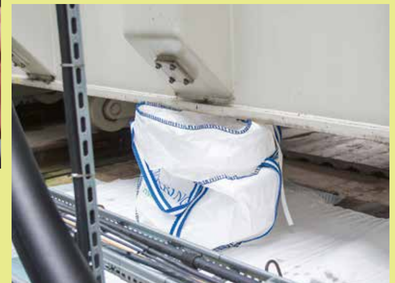
Espoon sähköasemalla havaittiin muuntajan öljyvuoto, jonka Mika Kärkkäinen kirjasi nopeasti mobiilisovellukseen ja päästiin käynnistämään torjuntatyöt.
