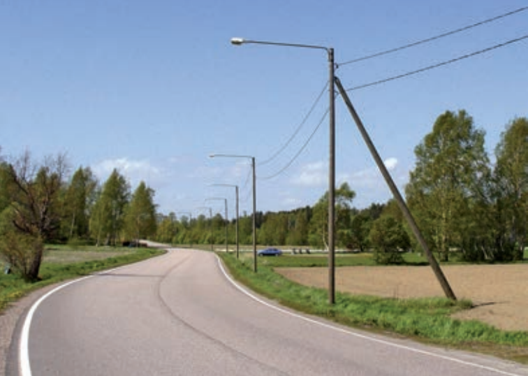
20 kV luftledning
