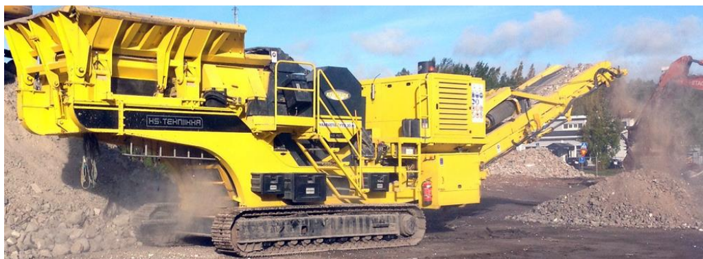
Kuva 12. Betonin murskausta siirrettävällä murskauslaitoksella (Gles 2021a).
