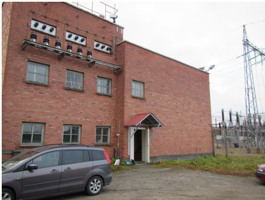
Kuva 18. Tihisenniemen purettu valvomorakennus (Fingrid).
