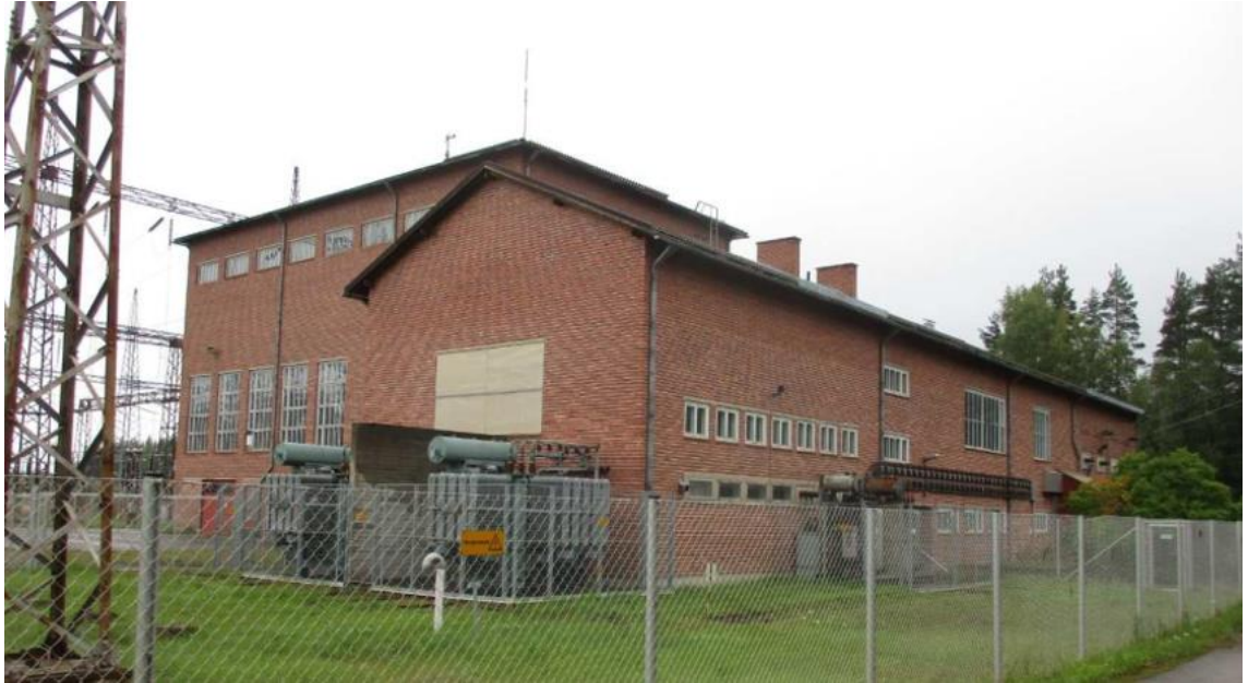
Kuva 6. Tiiliverhoiltu valvomorakennus (Fingrid kuva-arkisto).
