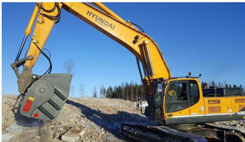
Kuva 11. Betonin murskausta murskakauhalla (Gles 2021a).
