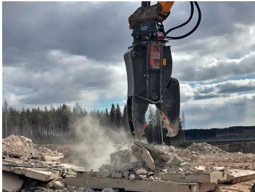
Kuva 10. Betonin pulverointia (Gles 2021b).
