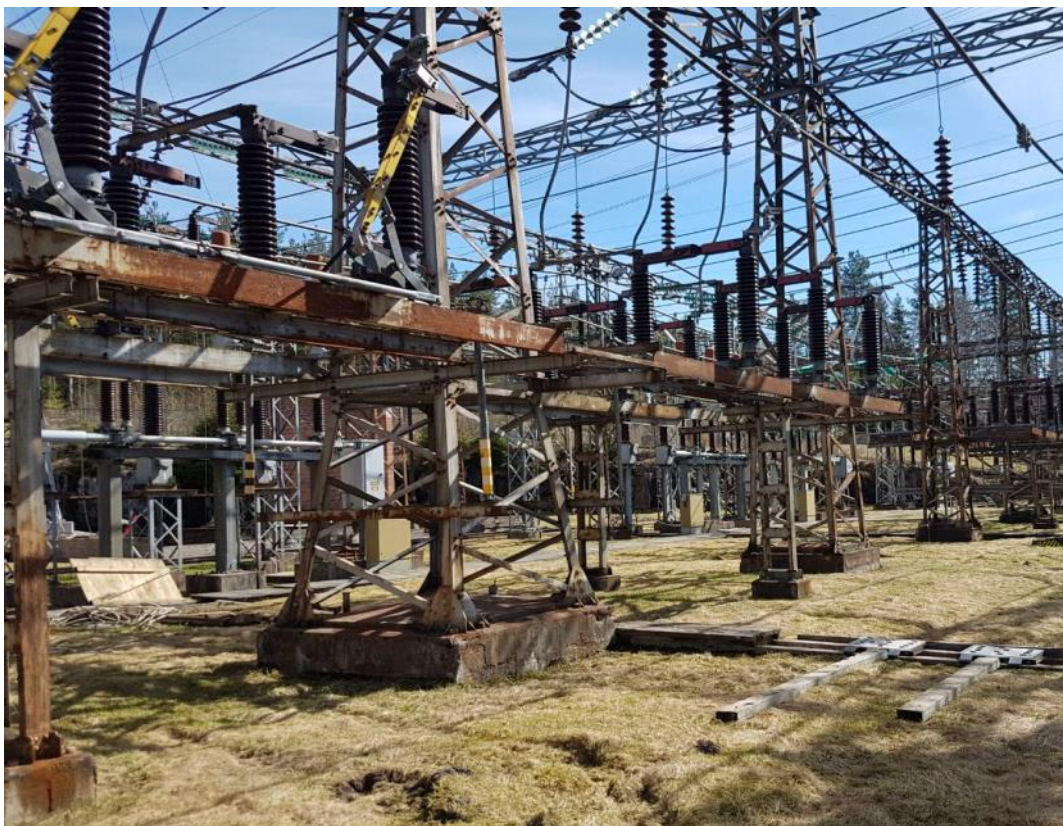
Kuva 17. Varkauden vanhan 110 kV kytkinlaitoksen laitteet olivat tulleet elinkaarensa päähän (Fingrid kuva-arkisto).
