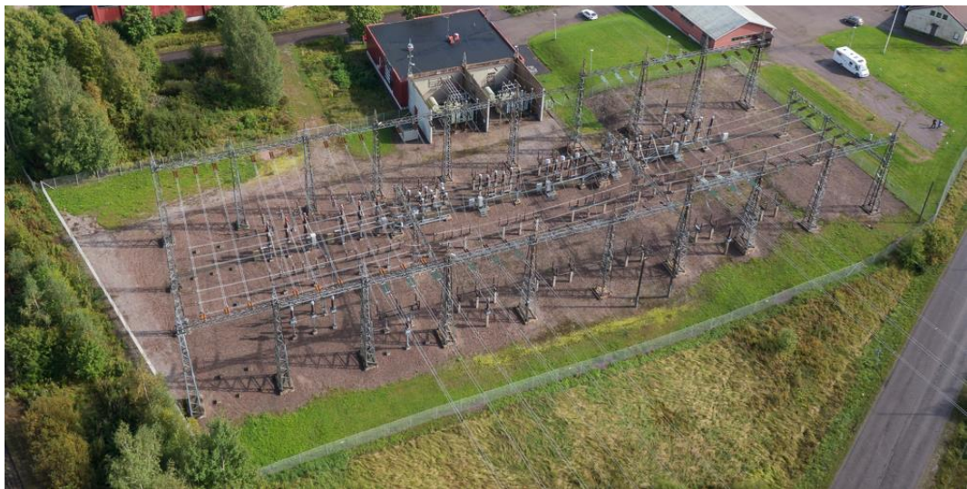
Kuva 16. Porvoon purettu 110 kV kytkinlaitos (Fingrid kuva-arkisto).
