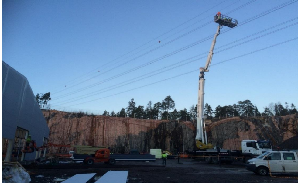
Kuva 2: Johtimen korjaus käynnissä 2.12 iltapäivällä.
