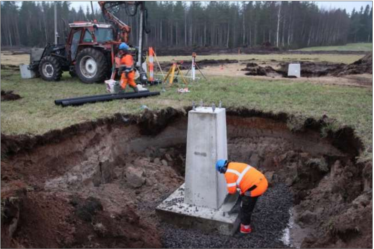
Kuva 5. Pylvään perustuselementin asentaminen.
