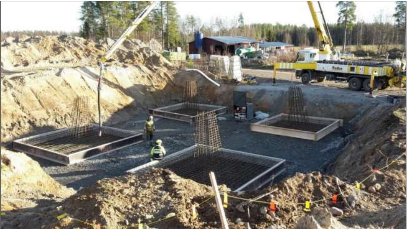
Kuva 6. Vapaasti seisovan pylvään perustuksen pohjatöitä.
