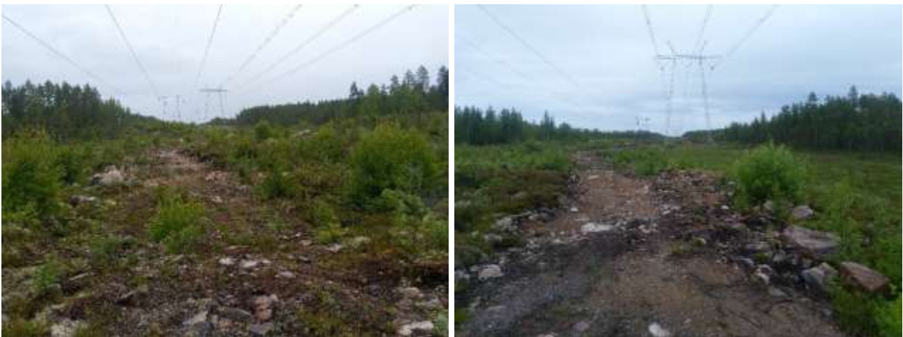
Kuva 9. Rakentamisaikana johtoalueelle syntyy paikoin kulku-uria, joiden kasvillisuus palautuu ajan myötä osittain. Pyhänselkä-Petäjävesi 400 kV voimajohto, noin kaksi vuotta rakentamisen jälkeen.
