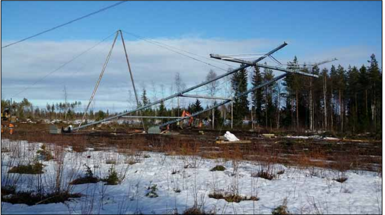
Kuva 11. Voimajohtopylvään pystytys.
