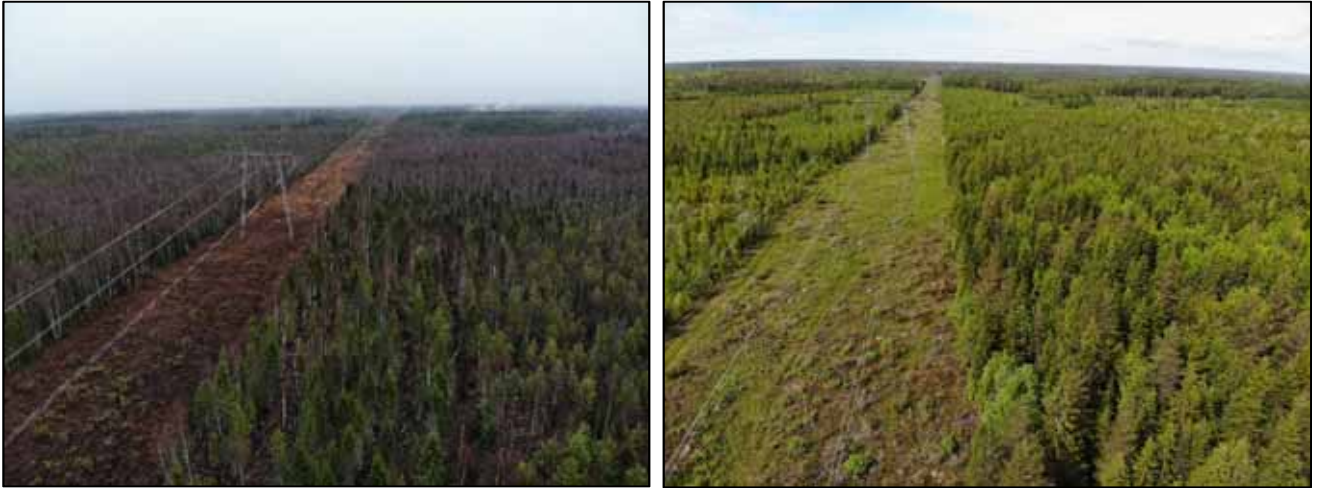
Kuva 72. Voimajohto sijoittuu nykyisen voimajohdon rinnalla talousmetsäalueille suurimmalla osalla johtoreittiä.
