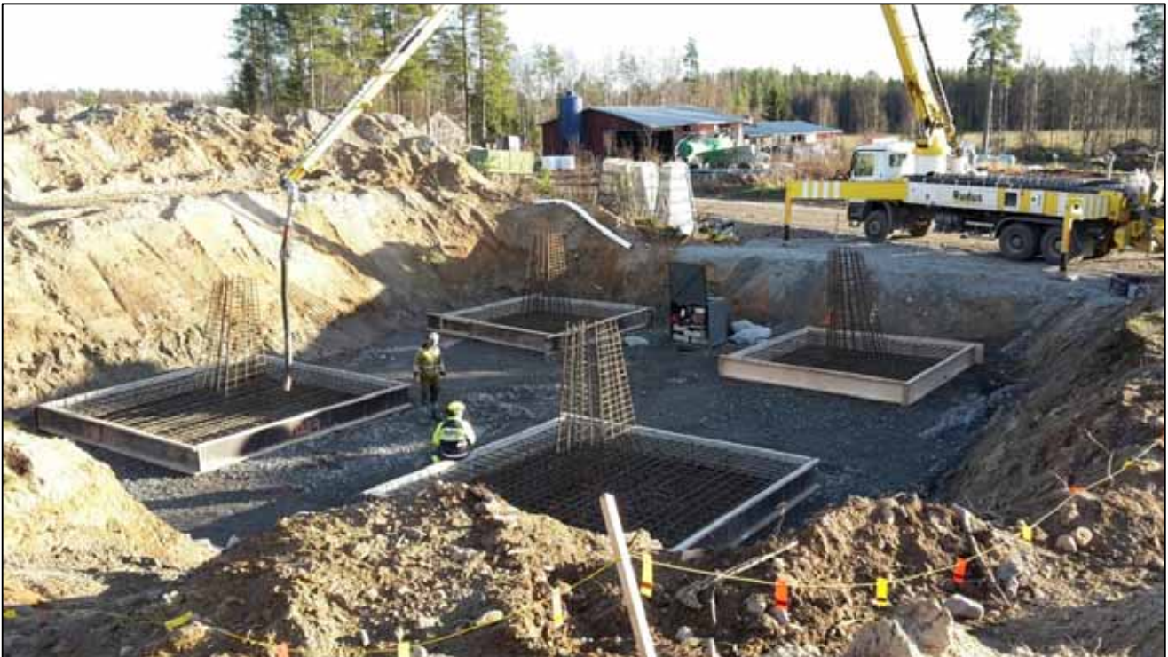
Kuva 10. Vapaasti seisovan pylvään perustuksen pohjatöitä.
