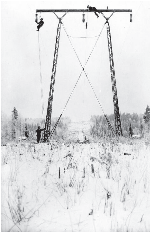
Voimajohtopylväissä työskentelyn turvavarusteet ovat kehittyneet huomattavasti kuvaushetken, eli 1930-luvun olosuhteista.
