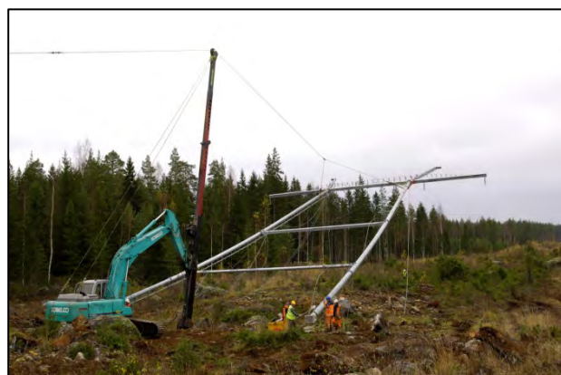
Kuva 11. Voimajohtopylvään pystytys.
