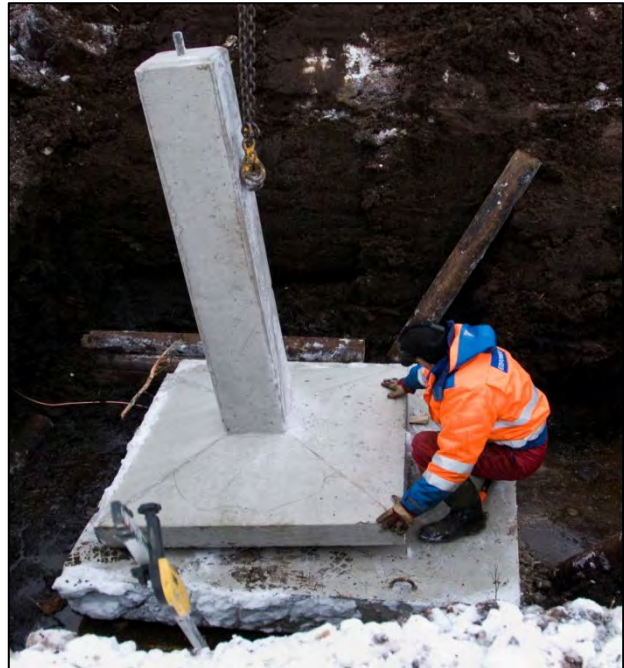
Kuva 7. Harustetun pylvään perustuselementin asentaminen.
