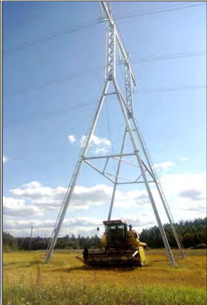
Kuva 21. Hankkeen perusratkaisuna käytettävä harustettu 400+110 kilovoltin portaalipylväs.
