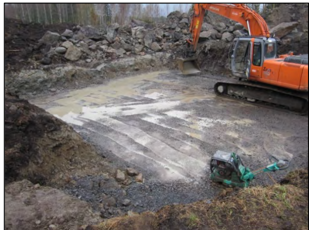
Kuva 8. Vapaasti seisovan pylvään perustuksen pohjatöitä.
