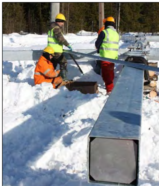
Kuva 10. Voimajohtopylvään kokoamista pylväspaikalla.
