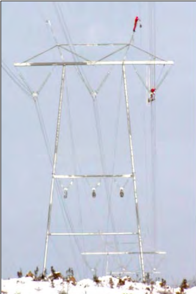
Kuva 21. Hankkeen perusratkaisuna käytettävä harustettu 400+110 kilovoltin portaalipylväs.
