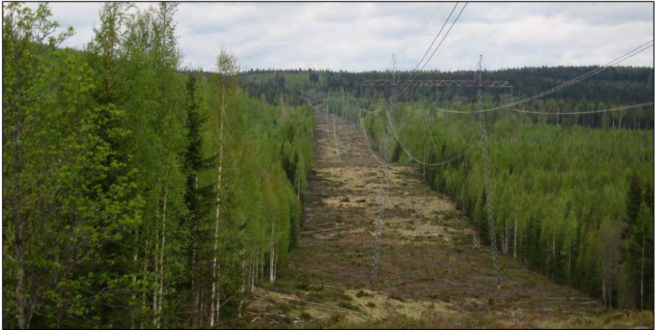
Kuva 33. Voimajohdolle raivataan puuttomana pidettävä johtoaukea.
