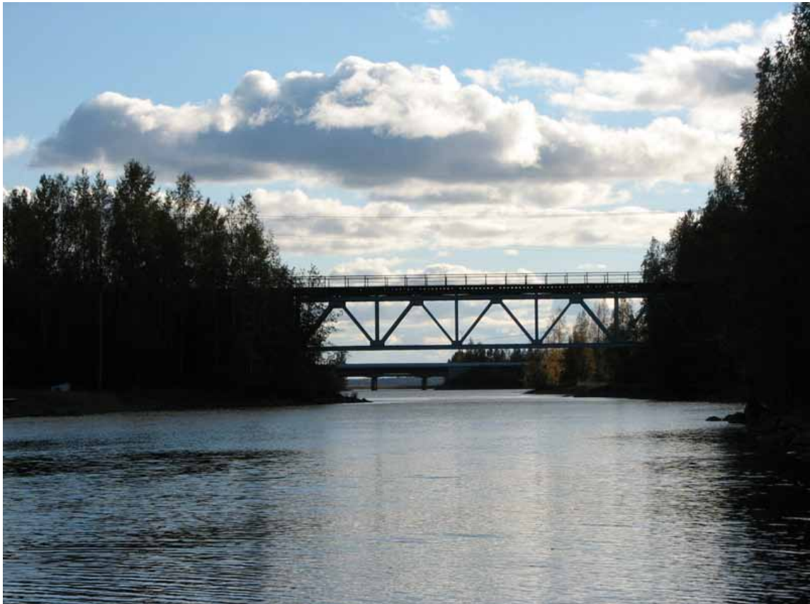
Kuva 40. Voimajohto ylittää Höytiäisen kanavan rautatiesillan ja maantiesillan välissä. Johtorakenteet eivät juurikaan erotu kaukomaisemassa.
