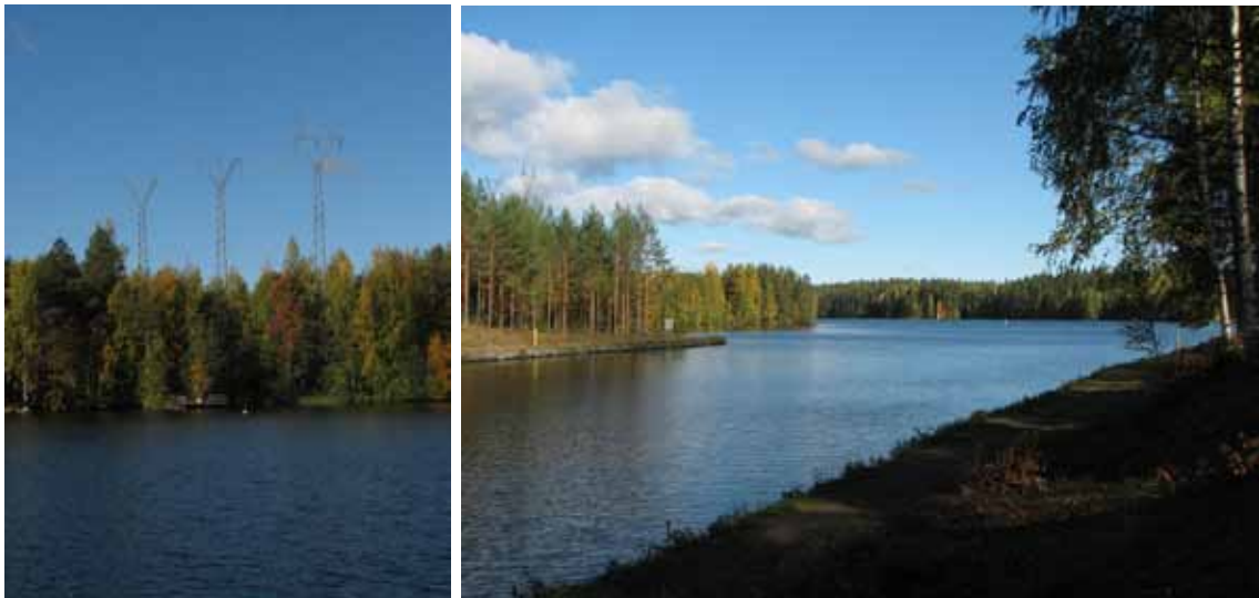
Kuva 36. Pussilantaipaleen kanava. Voimajohdot ylittävät kanavan korkealla, eivätkä johtimet tai pylväsrakenteet erotu juurikaan maisemassa muutoin kuin johtoalueen kohdalla.
