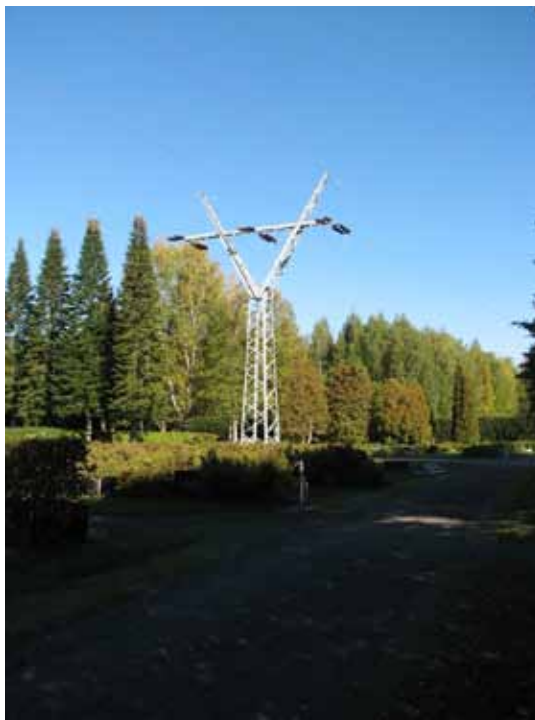
Kuva 28. Voimajohtopylväs Luttilan hautausmaalla.
