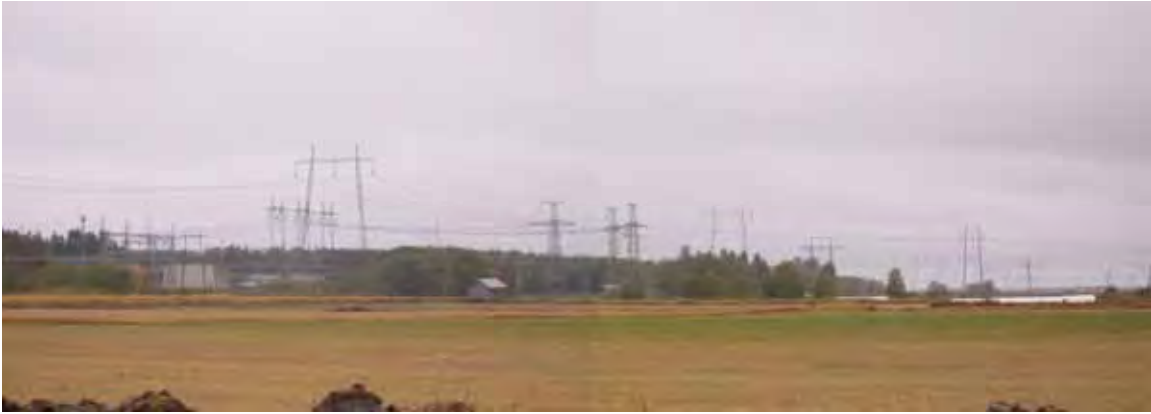
Kuva 11. Nykyiset voimajohtorakenteet maisema-alueen reunalla, Seinäjoen sähköasema vasemmalla.
