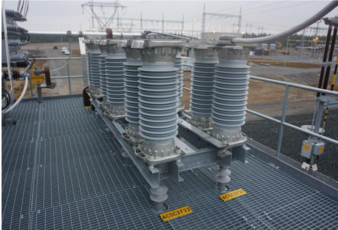
Kuva 3.2 Sarjakondensaattorilavalle sijoitetut varistorit [26]
