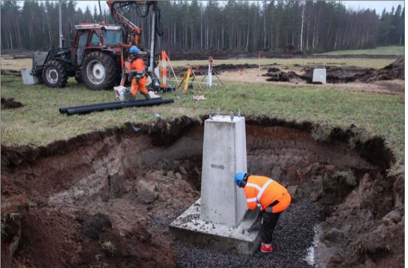
Kuva 5. Pylvään perustuselementin asentaminen.
