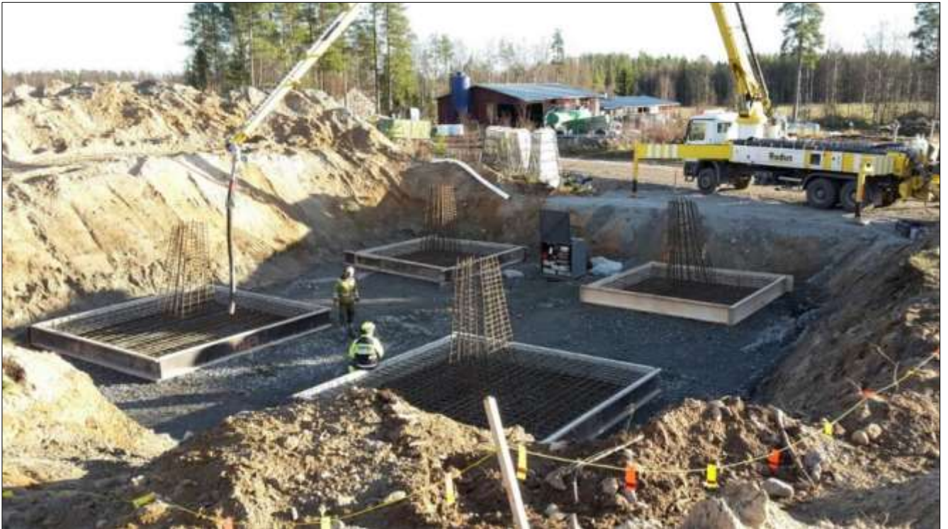
Kuva 6. Vapaasti seisovan pylvään perustuksen pohjatöitä.
