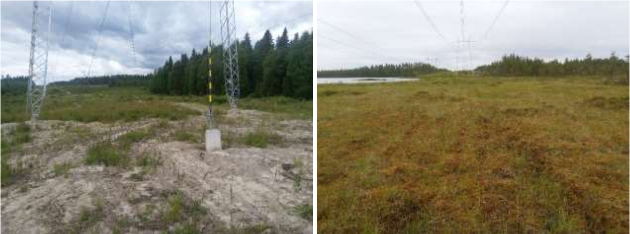
Kuva 8. Pylväspaikoilla kasvillisuus häviää tilapäisesti. Suoalueilla rakentamisesta ei jää juurikaan jälkiä, kun pylväät sijoitetaan mineraalimaan puolelle. Pyhänselkä-Petäjävesi 400 kV voimajohto, noin kaksi vuotta rakentamisen jälkeen.
