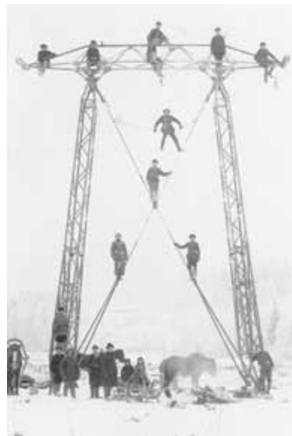
Kantaverkon ensimmäisten pylväiden pystyttäjät esittelevät työnsä tulosta.
