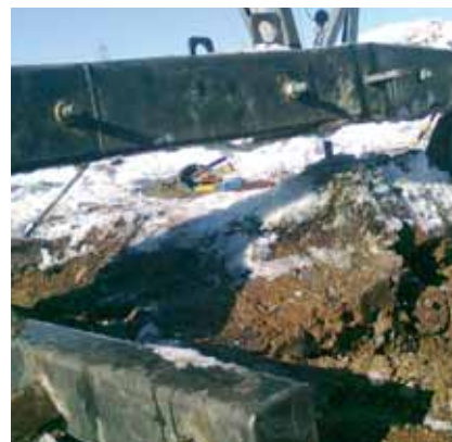
Palkittu apuväline, jonka varassa pylväsalkki pidetään väliaikaisesti ilmassa, kun perustuspilari jalan alta vaihdetaan. Pylväsalkkaa tarvitsee nostaa vain muutama tuuma, reilu tyvitapin mitta.
