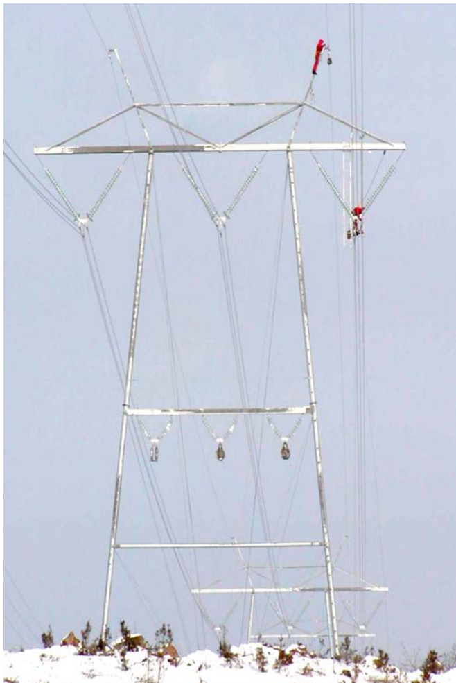
Kuva 10. Hankkeen perusratkaisuna käytettävä harustettu 400+110 kilovoltin portaalipylväs.
