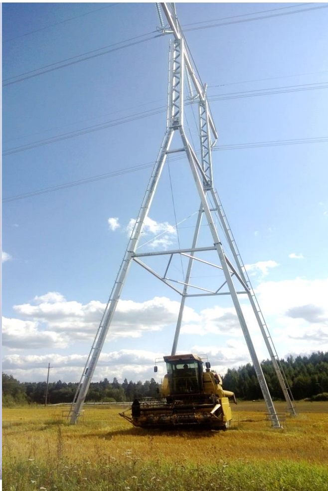
Kuva 10. Hankkeen perusratkaisuna käytettävä harustettu 400+110 kilovoltin portaalipylväs.
