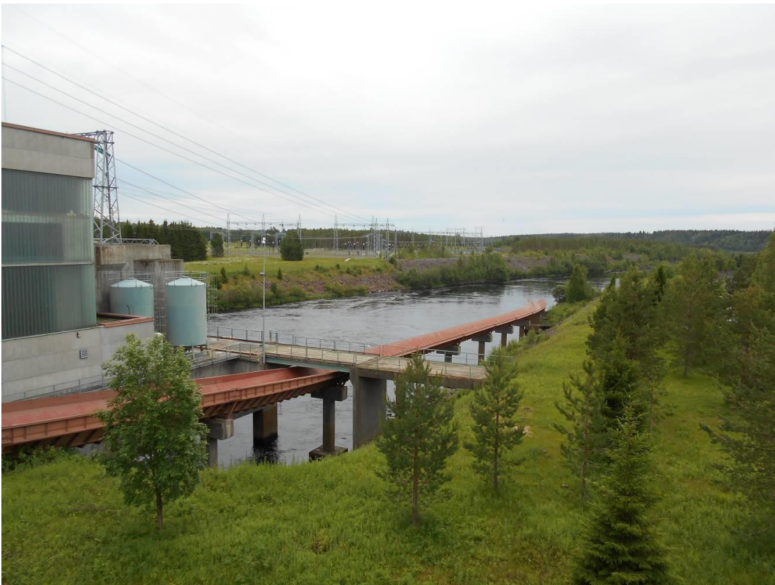
Kuva 4-3. Näkymä Kemijoen Taivalkosken vesivoimalaitokselta kohti Taivalkosken sähköasemaa ja hankkeen voimajohtoreittiä.
