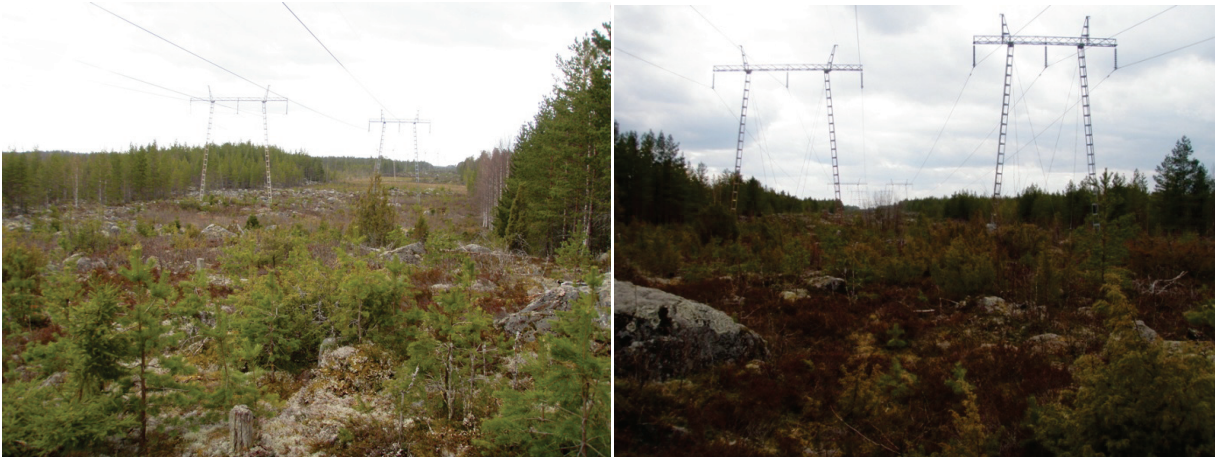
Kuva 4. Voimajohdot sijoittuvat metsäiseen ympäristöön, jossa muutamain paikoin on puustoisia suopainanteita. Voimajohtopylväät nousevat latvuksen yläpuolelle, kuten myös johtimet osittain. Taivasta vasten johtimet erottuvat paremmin kuin metsäistä taustaa vasten.
