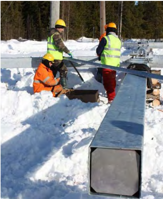
Kuva 3-5. Voimajohtopylvään kokoamista pylväspaikalla.
