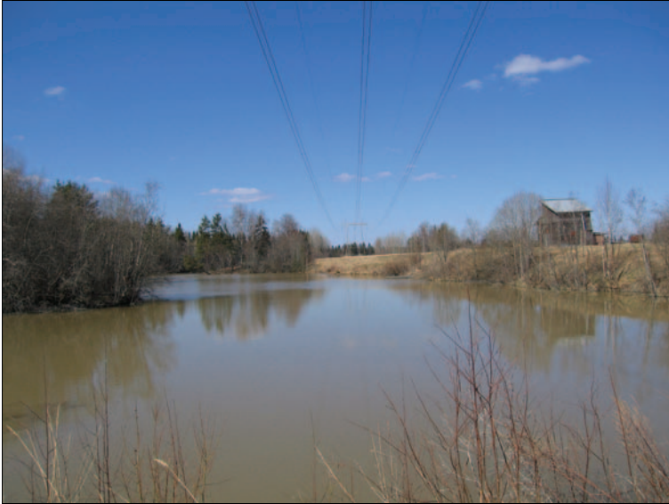
Kuva 13. Hallikkaanjoen ylityksessä voimajohto kulkee pitkään joen rantaan myötäillen. Korkeimpien pylväiden myötä maisemavaikutukset kasvavat.
