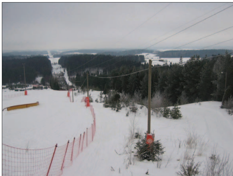
Kuva 9. Nykyinen 110 kV voimajohto Myllymäen laskettelukeskuksen alueella.
