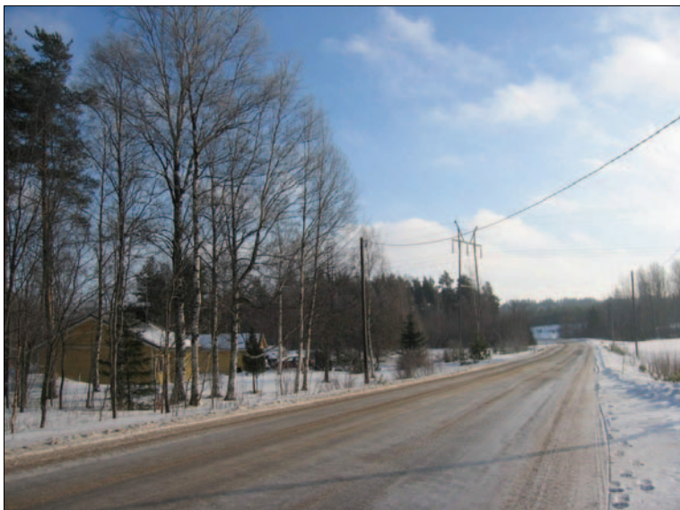
Kuva 6. Nykyinen 110 kV voimajohto Kuoppamäessä.
