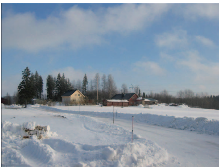
Kuva 7. Nykyinen 110 kV voimajohto Eiskolan Jokihaarassa.
