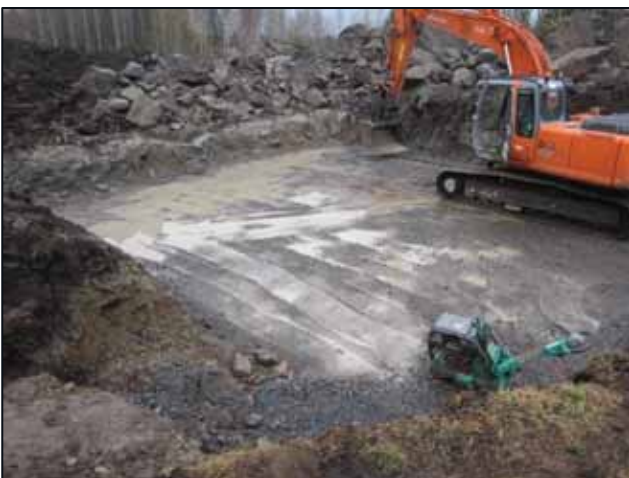
Kuva 3.5. Vapaasti seisovan pylvään perustuksen pohjattöitä.
