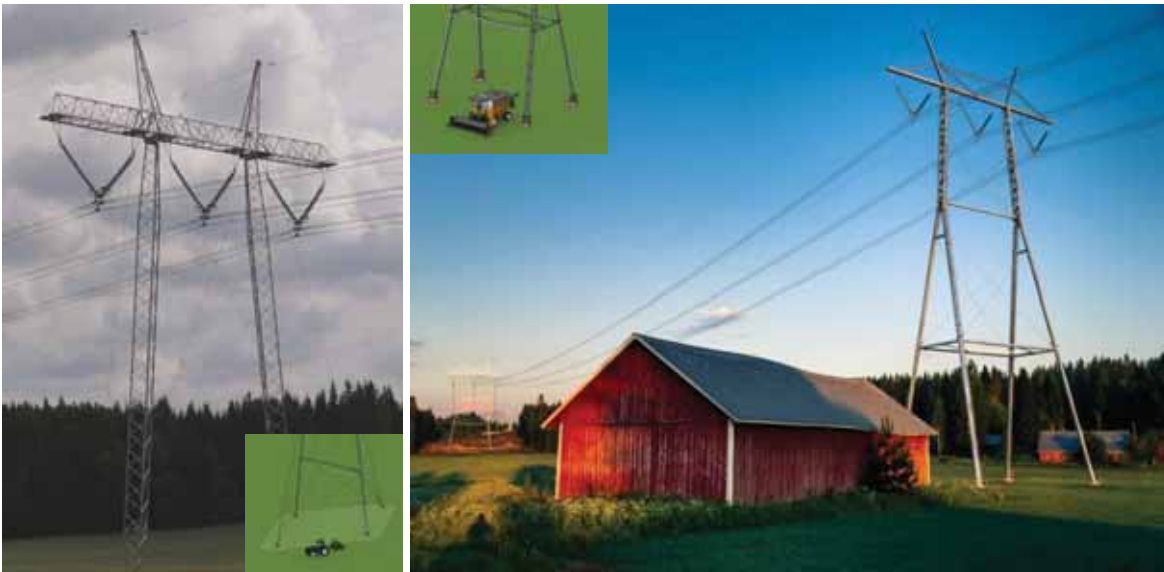
Kuva 4.17. 400 kilovoltin pylvästyyppejä. Vasemmalla harustettu portaalipylväs (peruspylvästyppi) ja oikealla harustamaton peltopylvästyppi.
