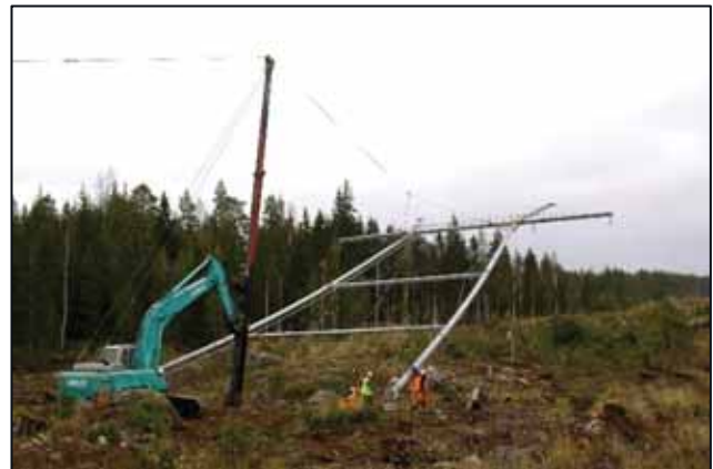
Kuva 3.7. Voimajohtopylvään pystytys.
