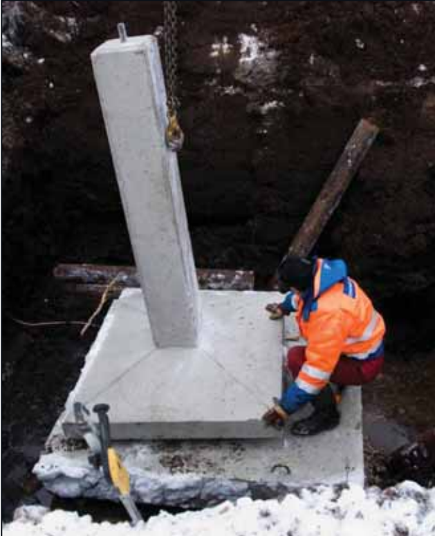
Kuva 3.4. Harustetun pylvään perustuselementin asentaminen.
