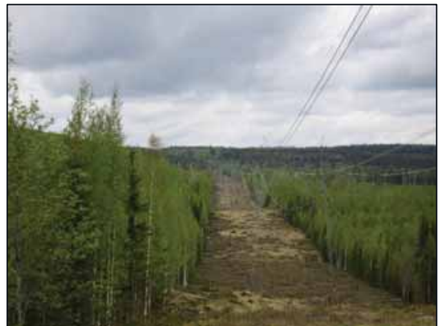
Kuva 6.1. Voimajohdolle raivataan puuttomana pidettävä johtoaukea.
