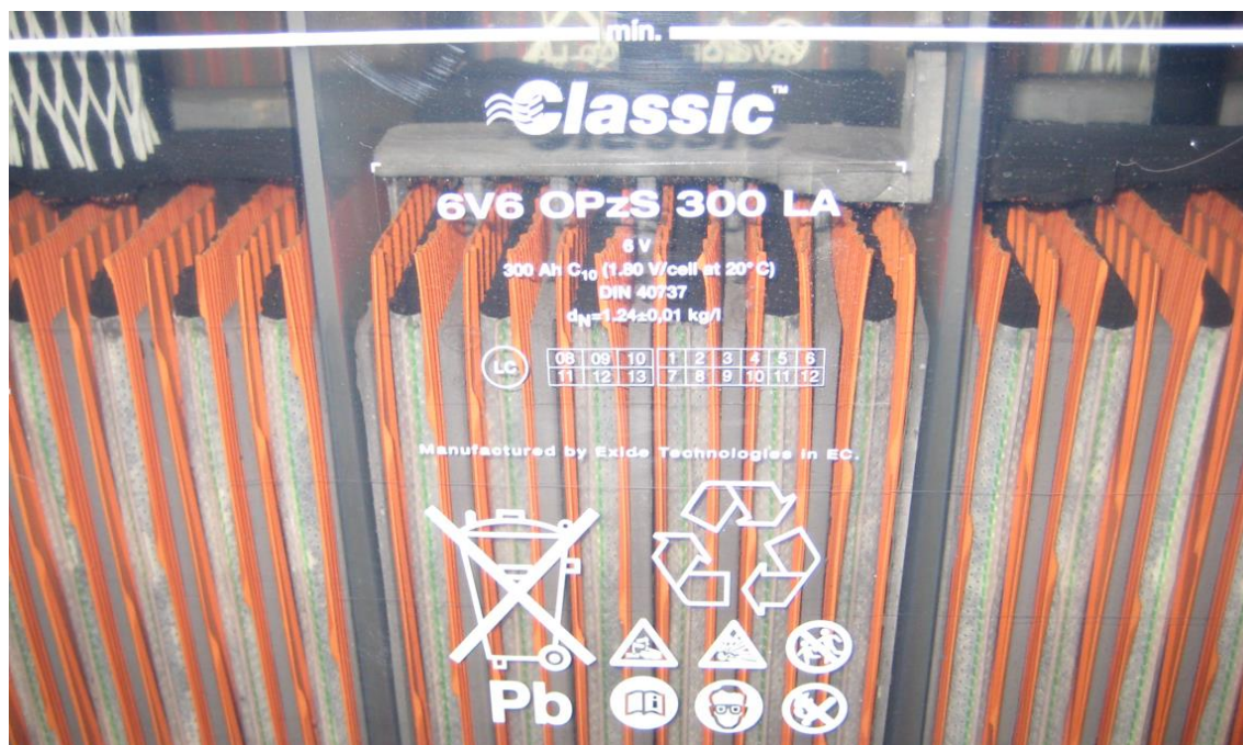
Kuva 4. Kolmekennoisen Classic 6 V 6 OPzS 300 LA ryhmäakuston kennorakenne [62].
