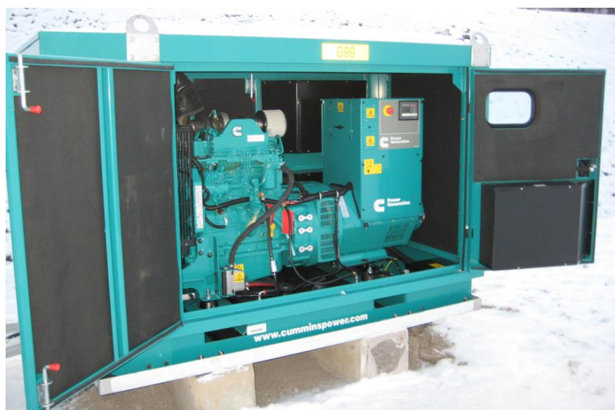
Kuva 7. Eräs Fingridillä käytössä oleva kiinteä varavoimakone [12].
