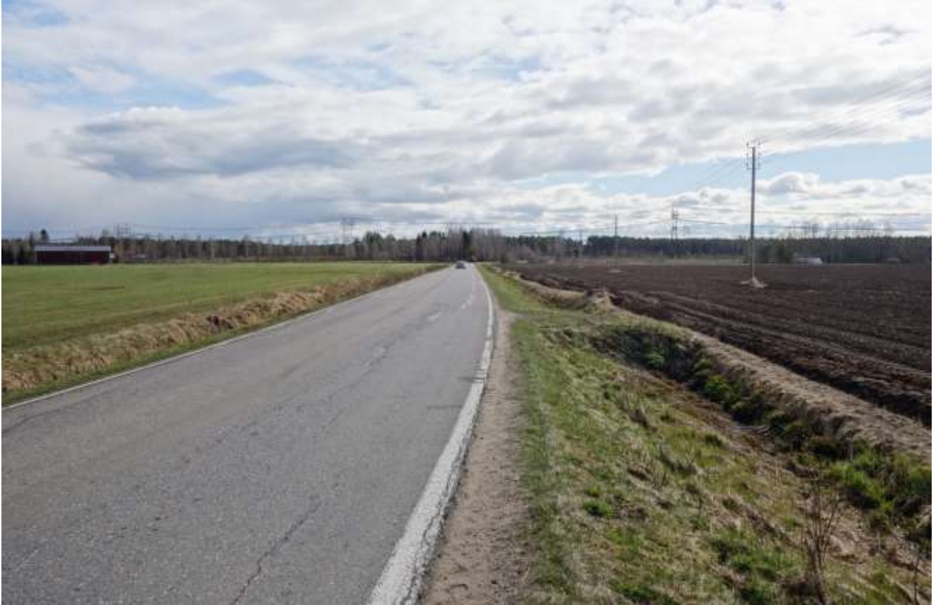
Kuva 7.31. Ojakylä, kuvauspaikka 4. Voimajohtoreittivaihtoehto B1 sijoittuu nykyisen voimajohdon etupuolelle lähemmäs kyläasutusta.
