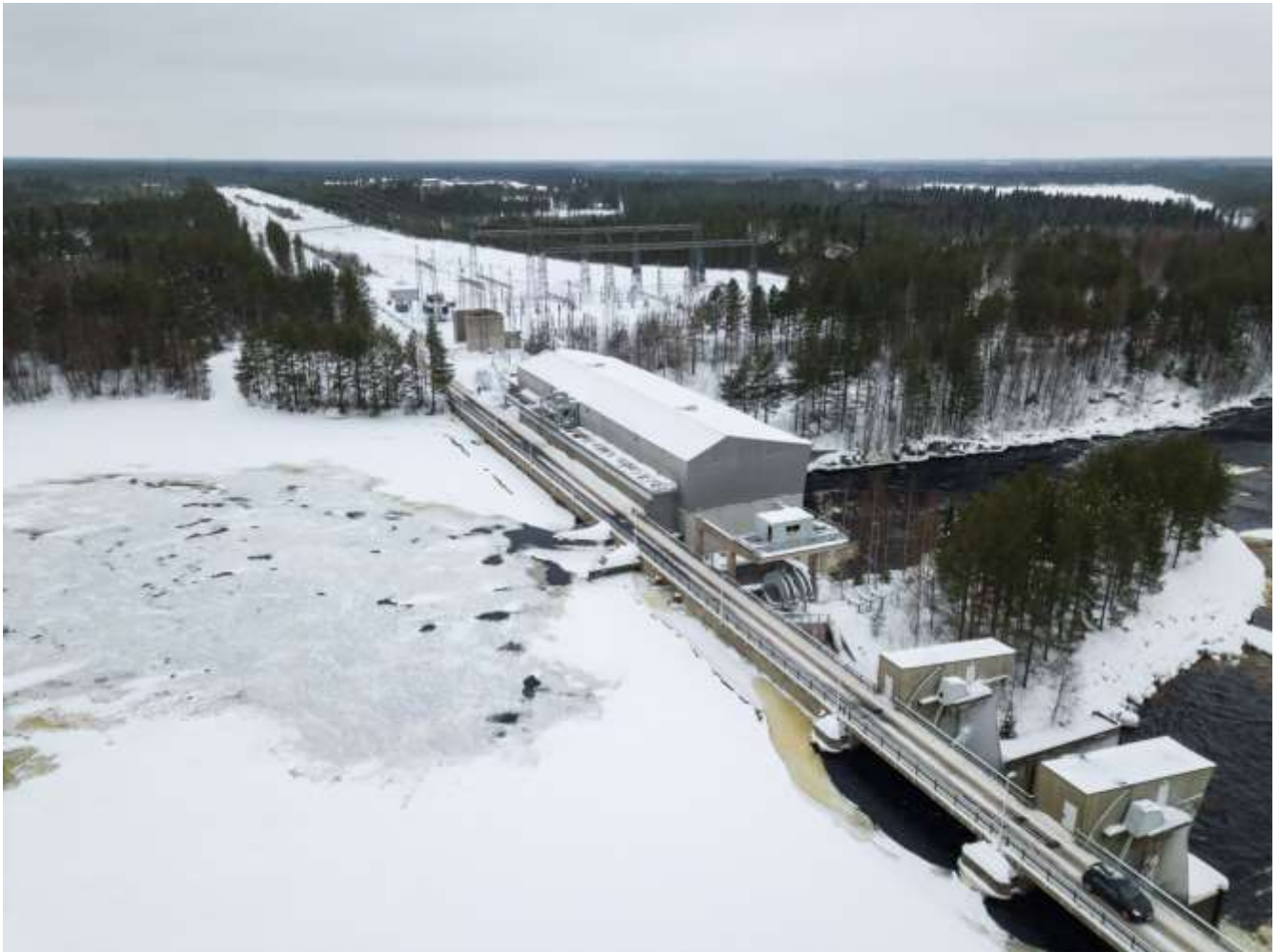
Kuva 7.49. Utasen voimalaitos, kuvauspaikka 3 Nykyinen voimajohto on purettu ja uusi voimajohto C on rakennettu johtoaukean oikeaan reunaan.
