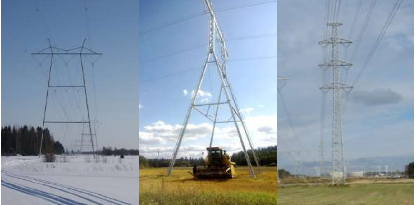
Kuva 4.4. Esimerkkikuvat eri pylvästyypeistä. Vasemmalla perusratkaisun mukainen 400+110 kilovoltin haruksin tuettu portaalipylväs, keskellä vapaasti seisova harukseton peltopylväs ja oikealla vapaasti seisova t-pylväs.
