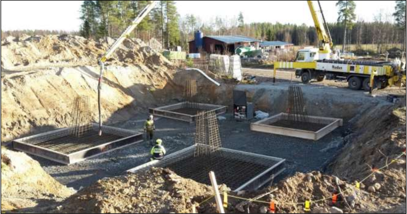
Kuva 3.5. Vapaasti seisovan pylvään perustuksen pohjatöitä.
