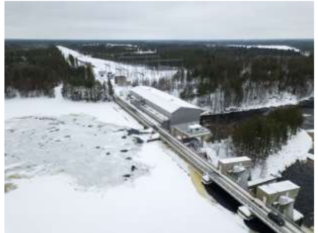
Kuva 7.48. Utasen voimalaitos, kuvauspaikka 3 Nykyinen voimajohto ja sähköasema.
