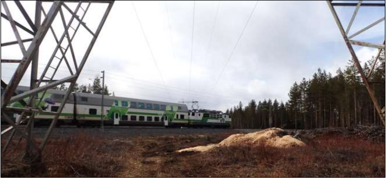
Kuva 8.29. Rautatien ja voimajohtoreitin risteyskohta reittiosuuksilla B1 ja B2.
