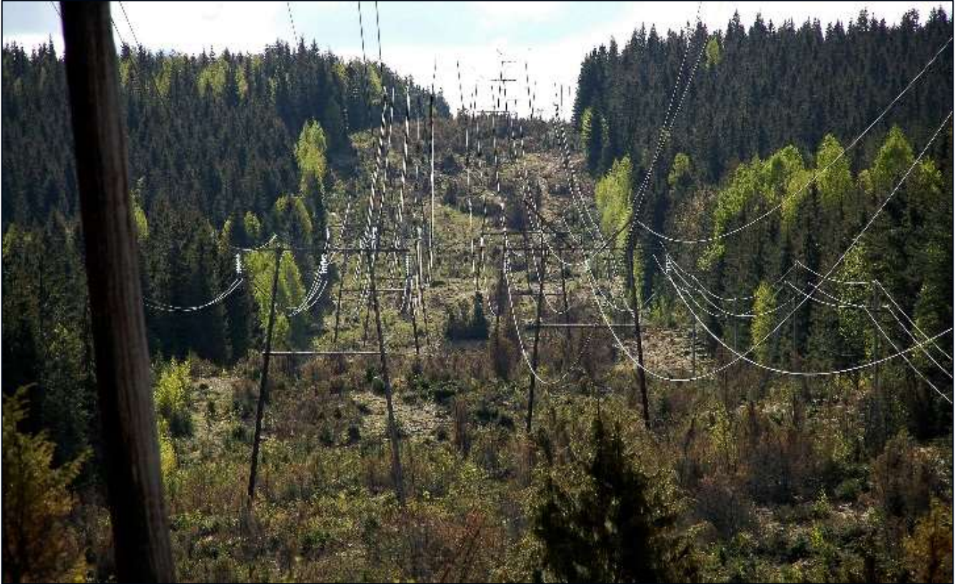
Kuva 3.7. Esimerkki valikoivasta raivauksesta.
