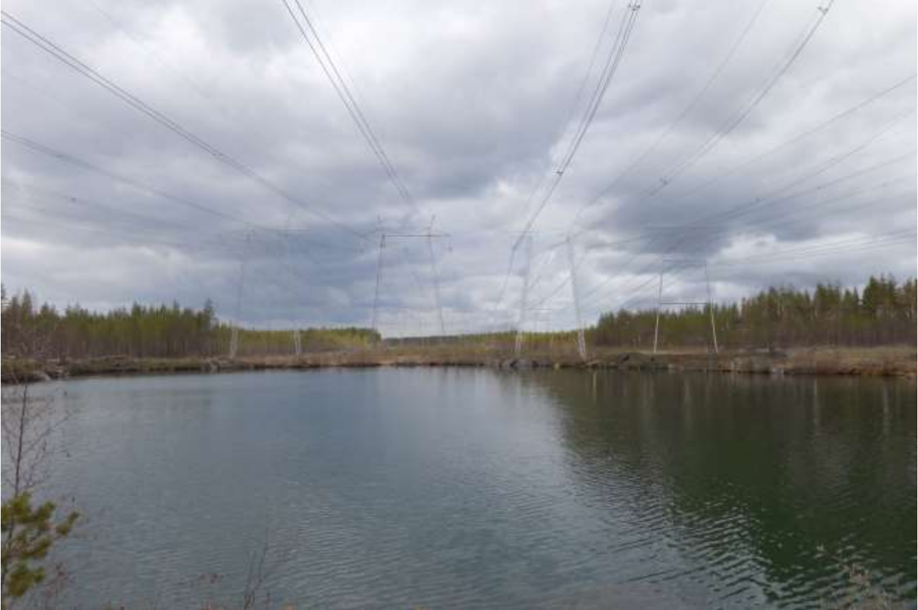
Kuva 7.23. Valokuviasovite Repokankaan uimapaikalta (havainnekuvan ottopaikka 1) johto-osuudelta A. Kuvaan on mallinnettu rakennettava Metsälinjan voimajohto ja suunniteltu Pyhänselkä-Nuojua voimajohto.
