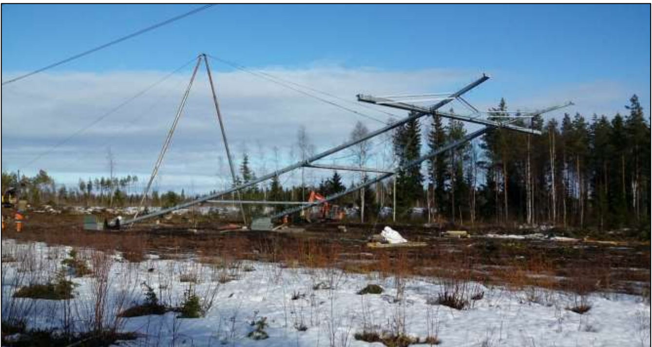
Kuva 3.6. Voimajohtopylvään pystytys.
