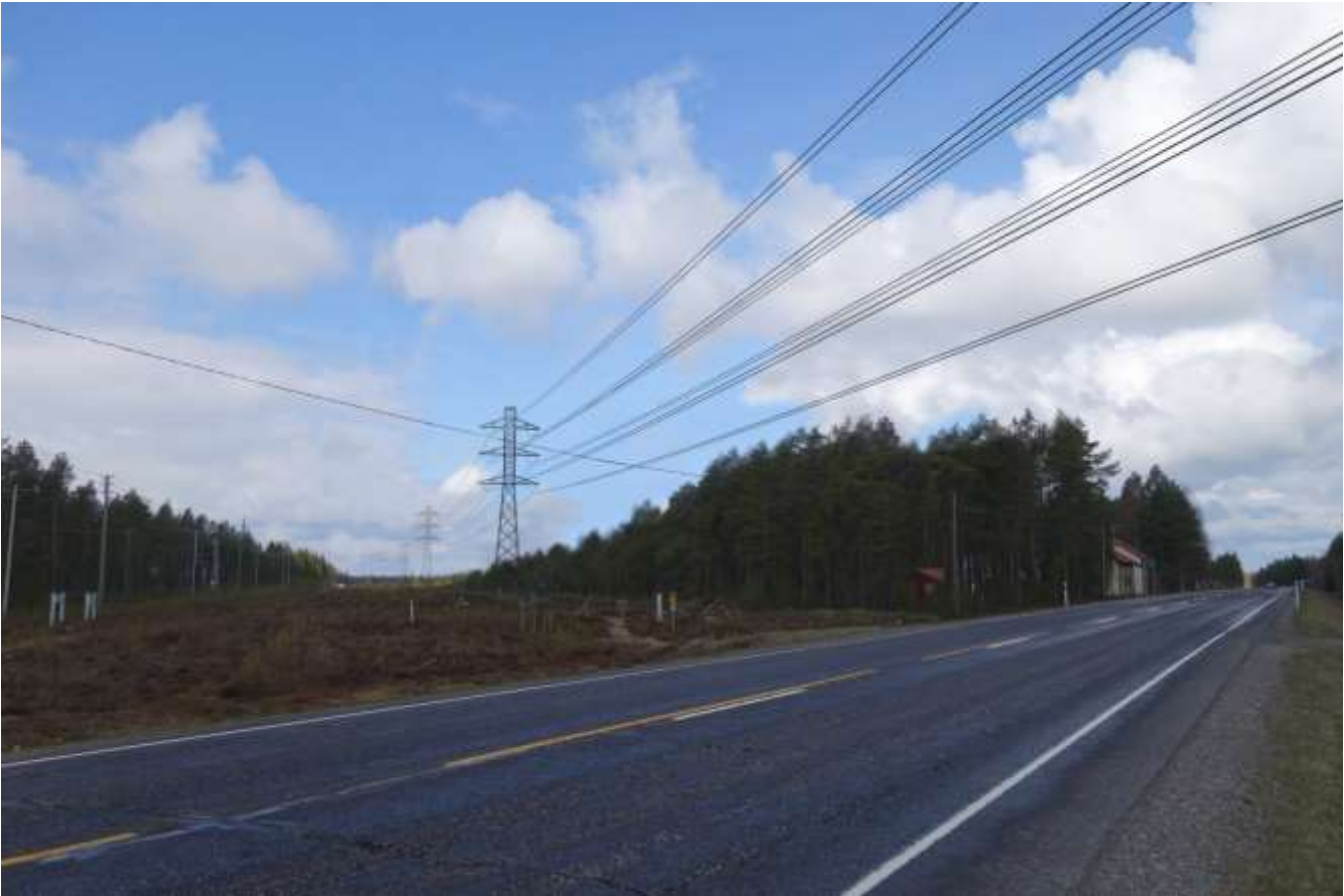
Kuva 7.26. Utanen. Asuinrakennukset Kajaanintien varressa voimajohdon läheisyydessä tilanteessa kun johto-osuus C on toteutunut (kuvauspaikka 2). Nykyinen voimajohto on purettu ja uusi voimajohto rakennettu lähemmäs asuinrakennuksia. Voimajohdon ja rakennusten väliin jää edelleen suojapuustoa.
