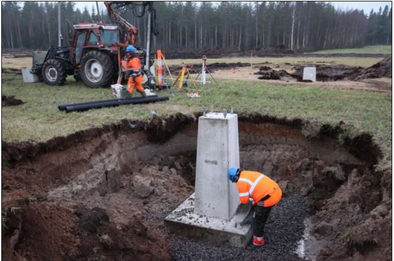
Kuva 3.4. Pylvään perustuselementin asentaminen.
