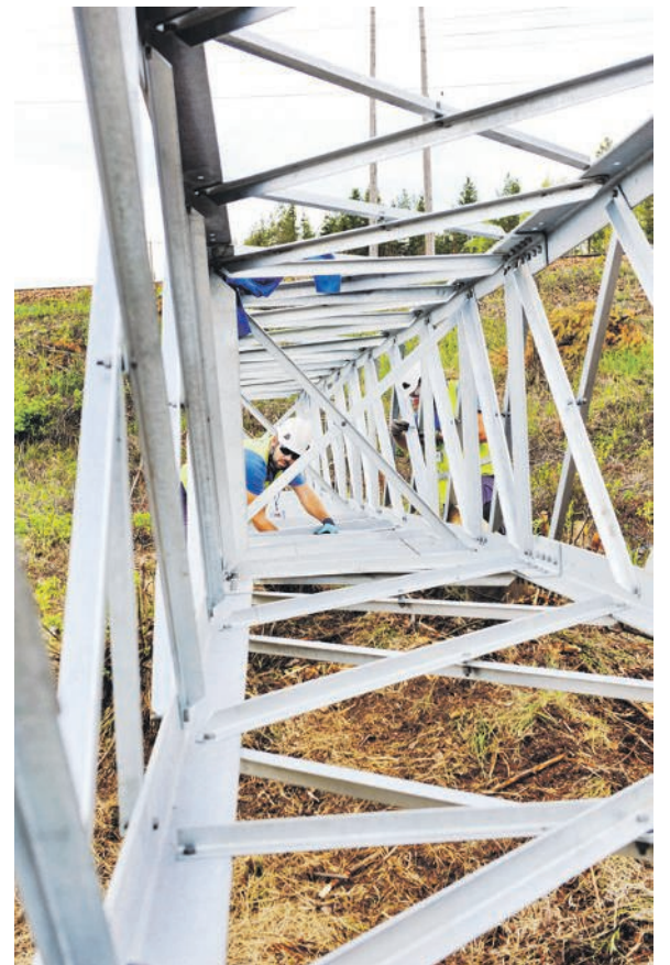
Fingrid kehittää työturvallisuutta jatkuvasti ja pitkäjänteisesti.
