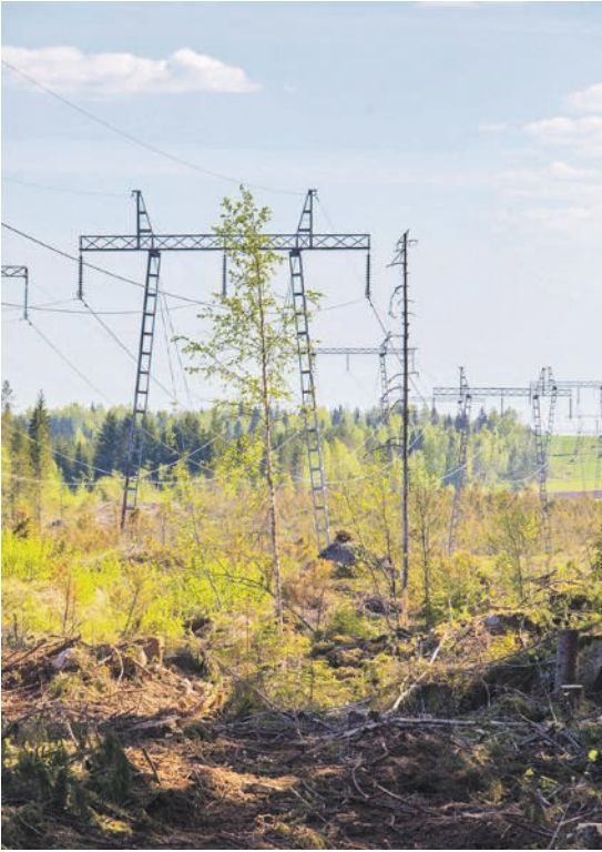
Voimajohdon reunavyöhykehakkuista tehdään vuosittain noin 630 kilometrin matkalta.
