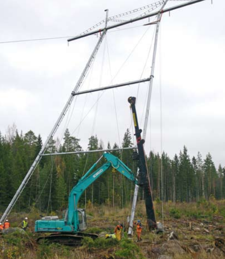
400 + 110 kV yhteispylvään pystytys meneillään.
