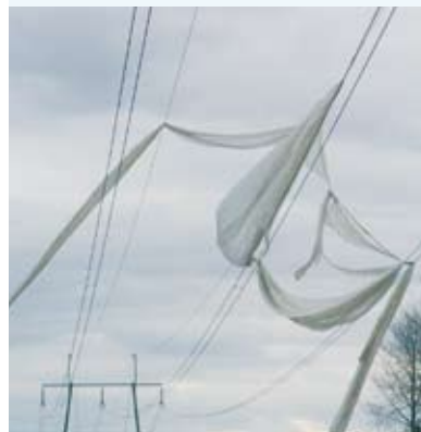
Kevätkylvöjen peiteharsojen kanssa on oltava huolellinen ja varottava, etteivät ne lennä voimajohtoihin. Johtoihin takertuneet harsot on aina turvallisuussyistä jätettävä ammattilaisten irrottaviksi, koska vähänkin kostunut tai likaantunut harso johtaa sähköä.
