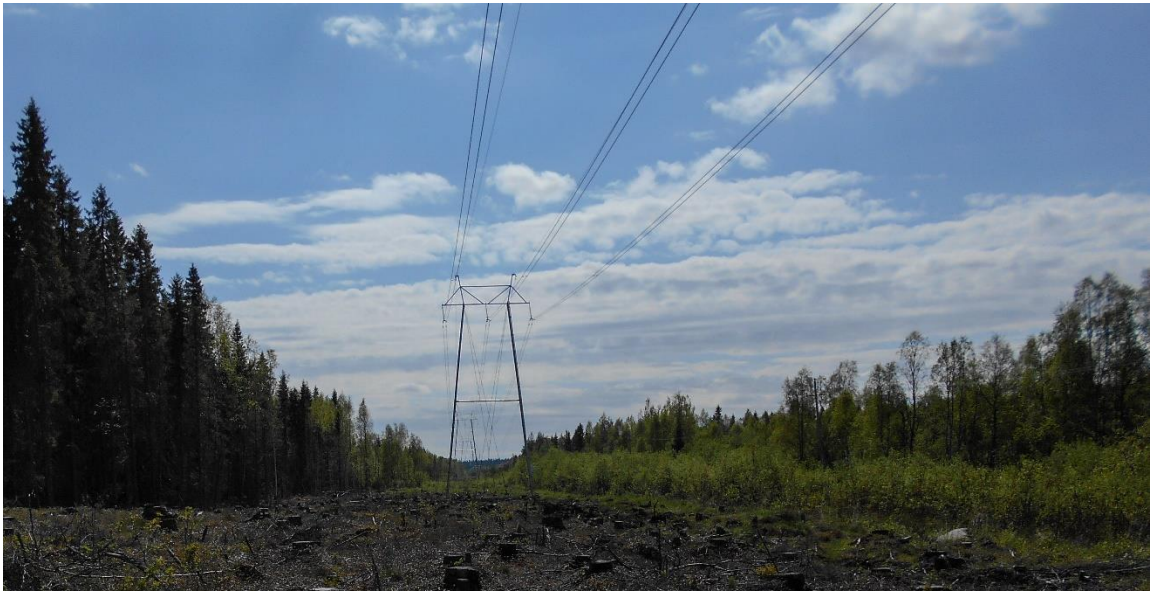
Kuva 5-3. Näkymä etelään osuudella B–C, jolla voimajohto sijoittuu nykyisen voimajohdon länsipuolelle (kuvassa oikealla, kuvaussuunta etelään).
