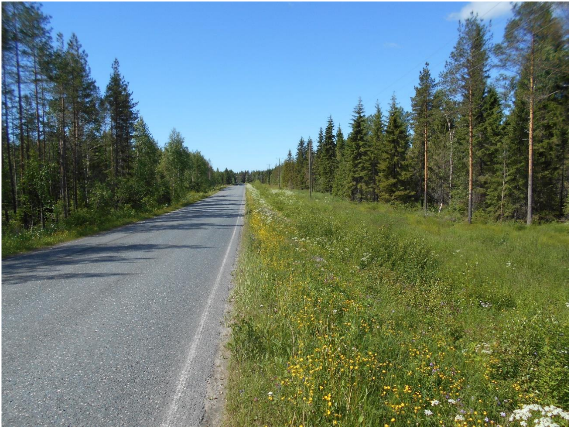
Kuva 5-6. Voimajohtoreitti ylittää Kivalontien. Voimajohdon rakentamisen yhteydessä Kivalontietä reunustavien metsäalueiden puustoon raivataan avoin maastokäytävä, ja voimajohdot ylittävät tien. Näkymä länsi-lounaaseen osuudella A–B.
