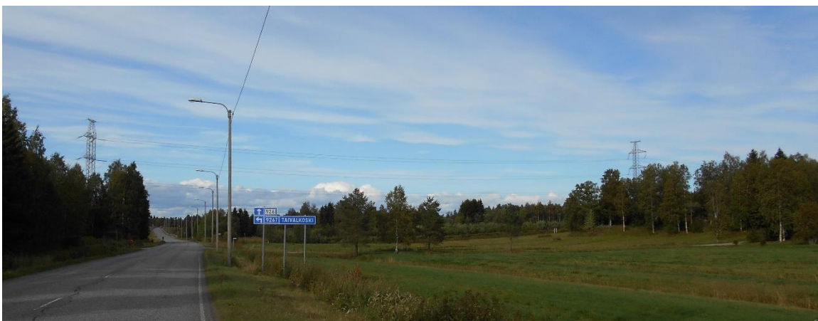
Kuva 5-1. Voimajohto ylittää Tervolantien osuudella C–D. Voimajohto sijoittuu nykyiselle johtoalueelle nykyisen voimajohdon eteläpuolelle (näkymä etelästä). Taivalkosken sähköasema sijoittuu kuvassa vasemmalle.
