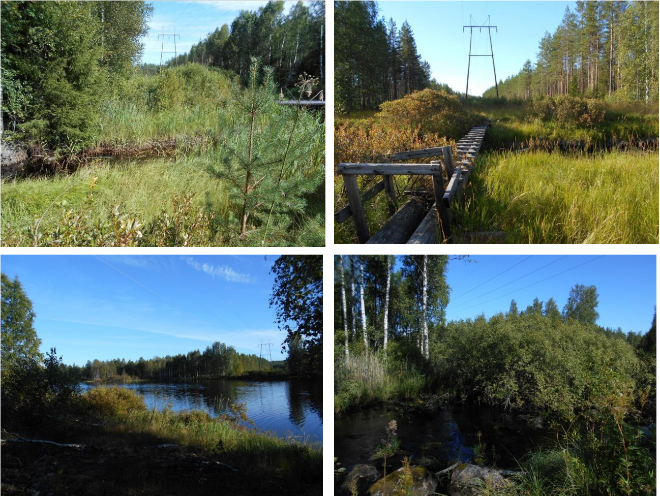
Kuva 4-1. Honkajoen yli kulkee moottorikelkkareitin silta (ylävas., silta kuva oikeassa reunassa). Koukkujoen yli on tehty kulkusilta (yläoik.). Voimajohtoreitti ylittää Koitajoen (alavas.) ja Palojoen (alaoik.).
