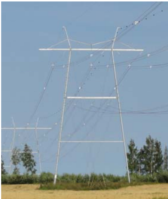
Kuva 9. Harustettu 400 + 110 kV portaalipylväs.
