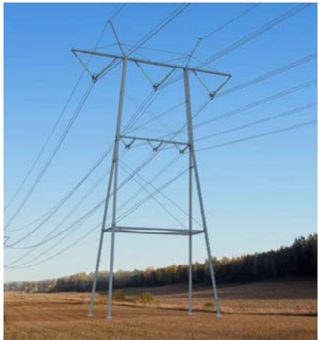
Kuva 10. Harustamaton 400 + 110 kV portaalipylväs (havainnekuva).
