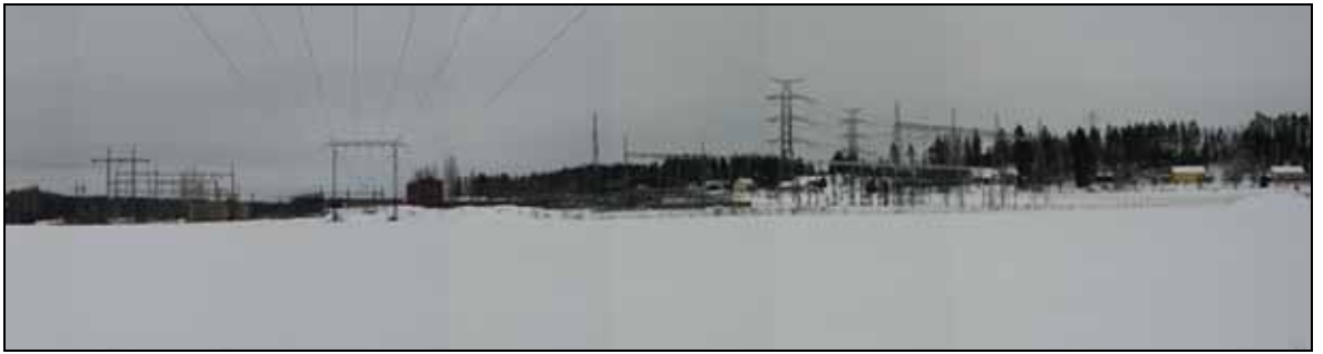
Kuva 30. Hikiän sähköasema-alue etelästä johtoreitin suunnasta katsottuna.
