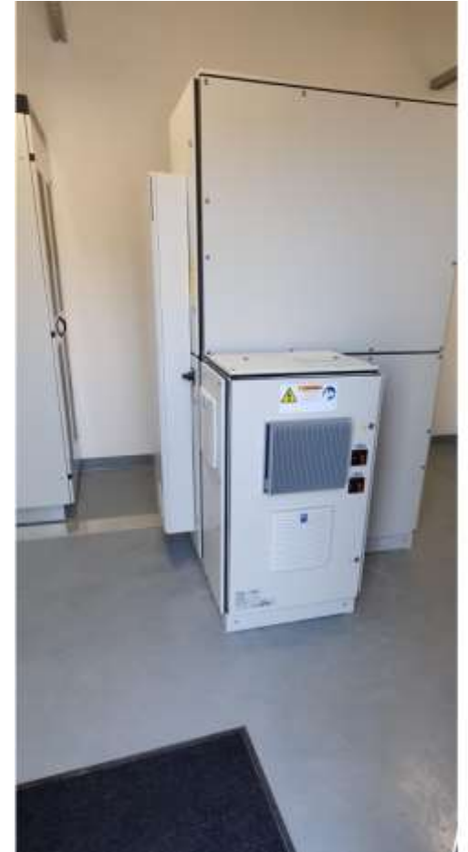
Sarvisuo PPC mk5. Sisällä Elspecin laite joka "lukee verkon taajuutta".
